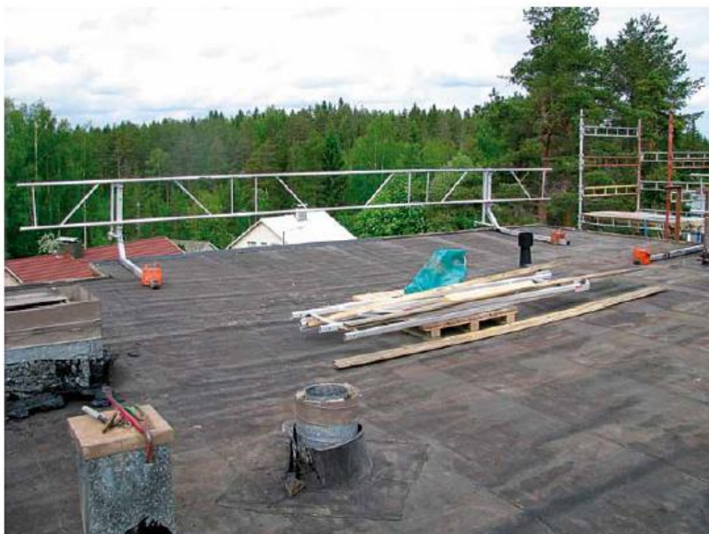
Kuva 2. Yleiskuva katolla olevista tarvikkeista ja kaiteista.
