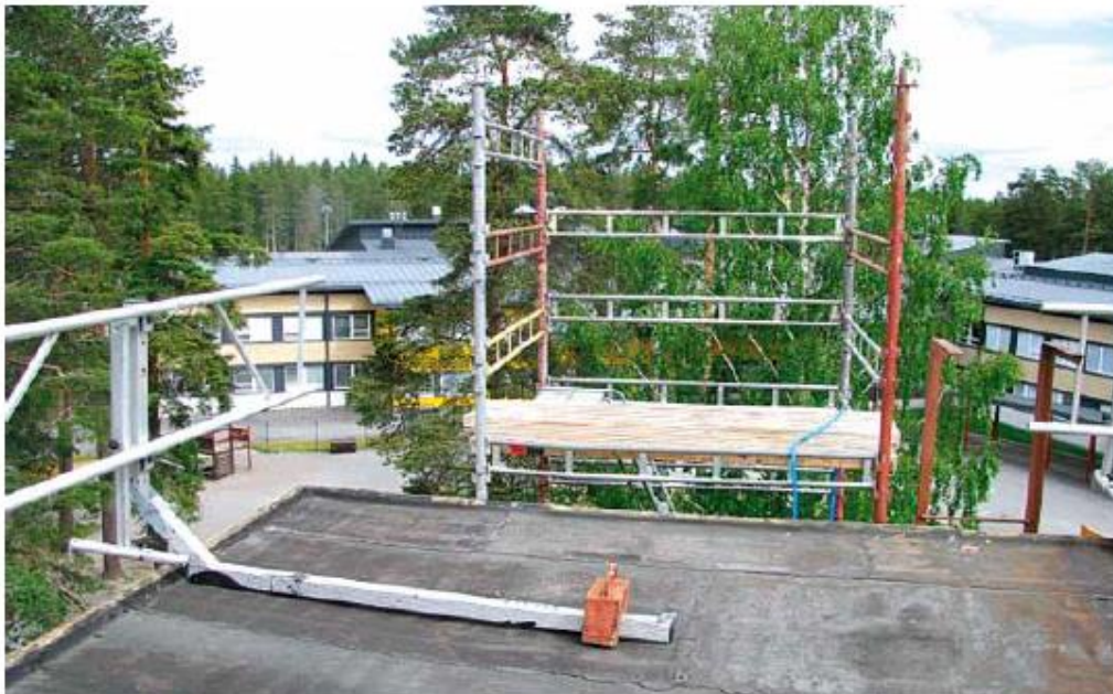
Kuva 1. Katolle rakennetun porrastornin yläosa ja pystytettyjä vastapainokaitteita.
