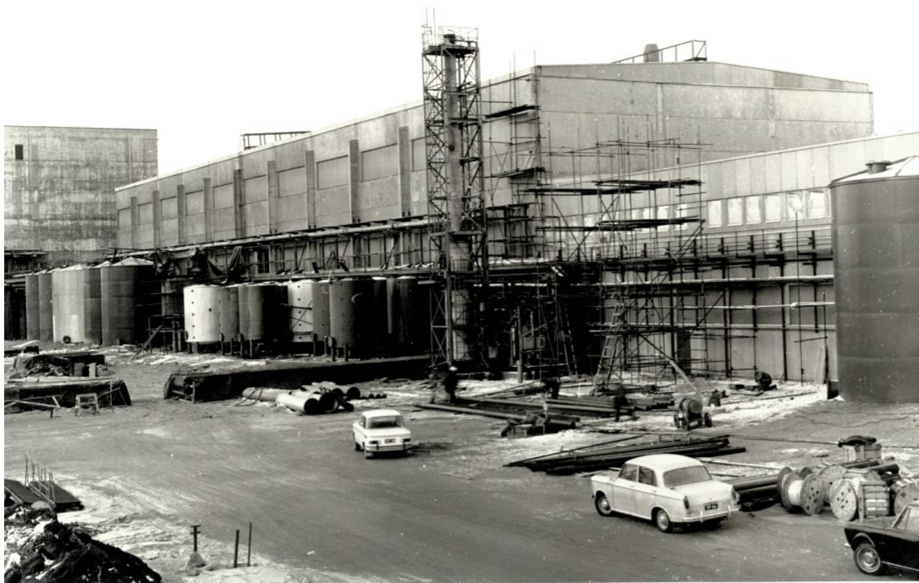
KUVA 2. Outokumpu Kokkolan tehtaiden 2. linjan rakennustyömaa 14.12.1966
