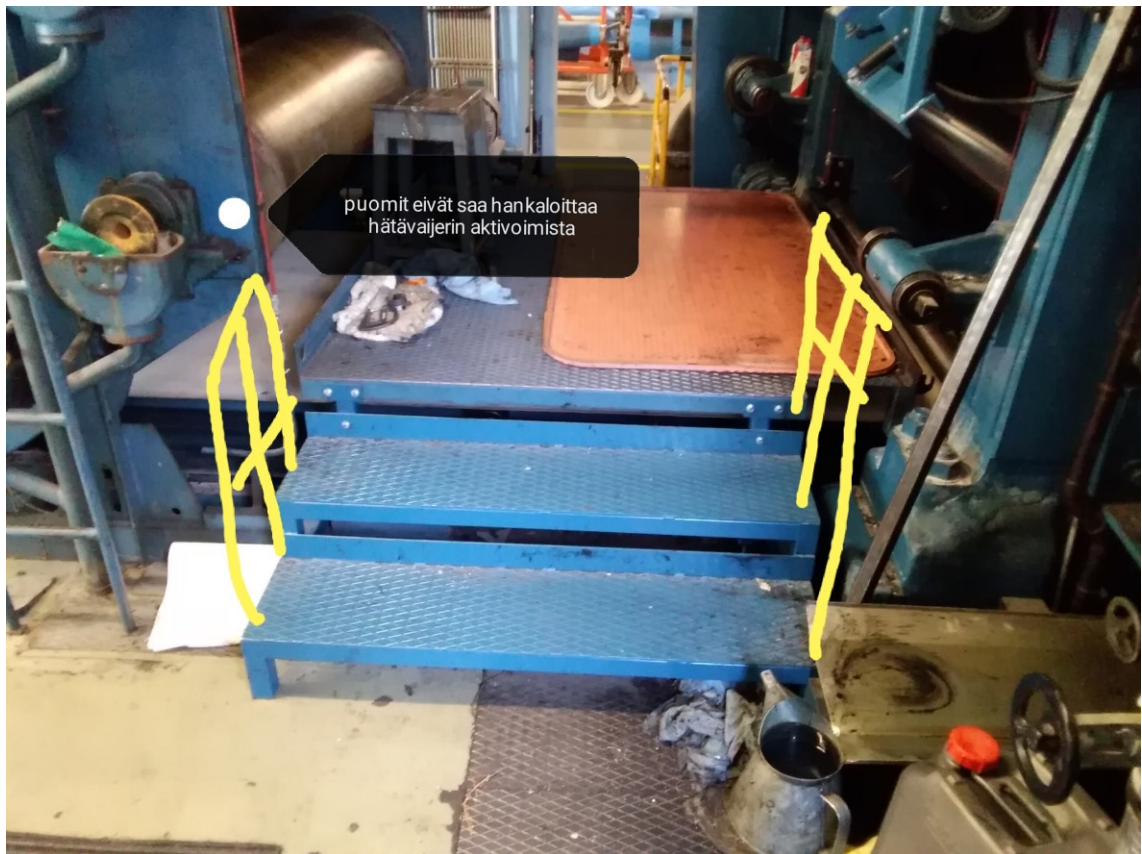
KUVA 19. Työtasolle vievät portaat ikkunan puolelta
