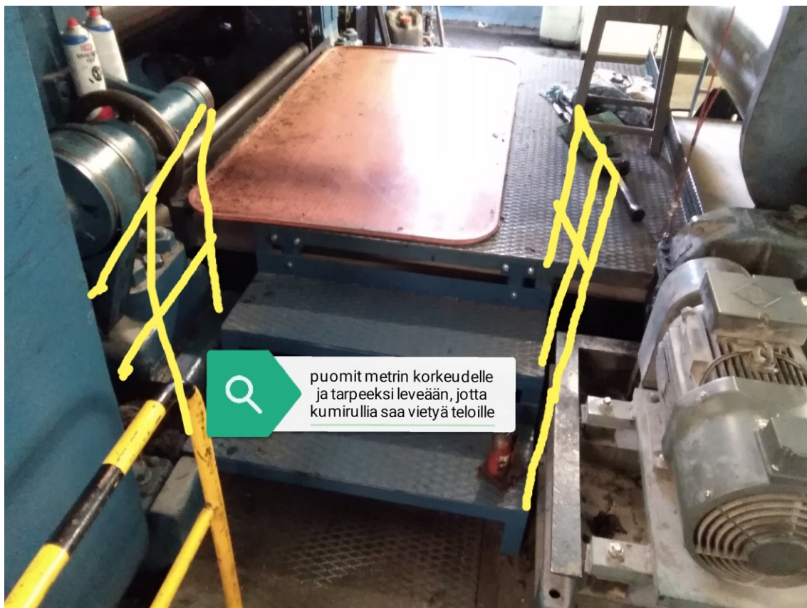
KUVA 20. Työtasolle vievät portaat käytävän puolelta
