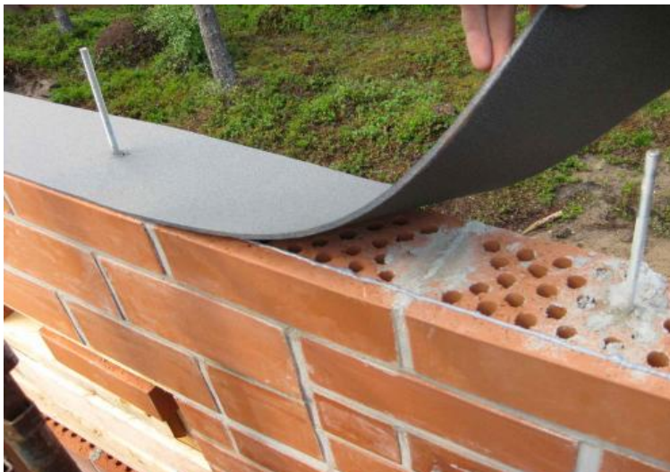
KUVA 24. Seinän ja yläjuoksun liittyminen
