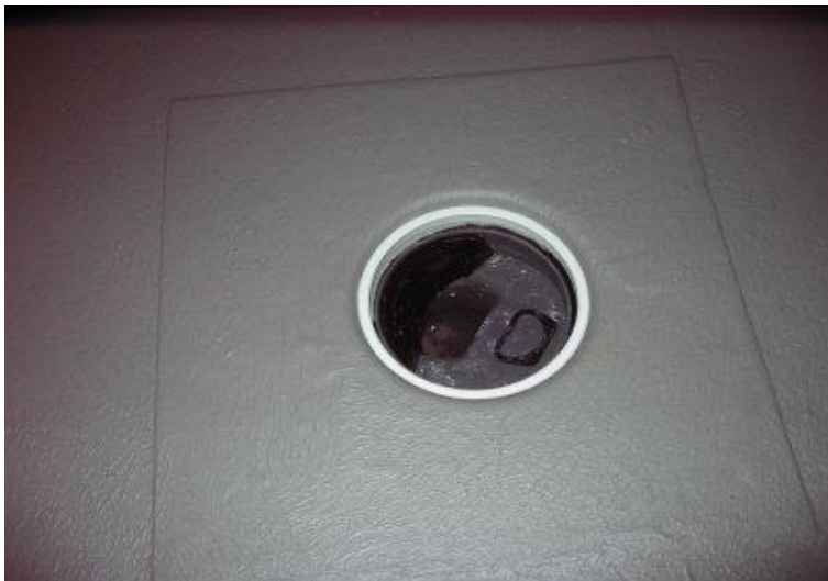
KUVA 33. Kaivolaipalla tehty lattiakaivon vedeneristys
