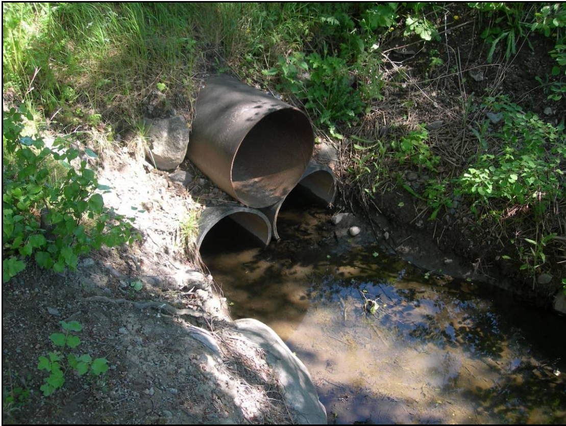
Kuva 21. Hulevesiputkia Kustaanlinnanpuistossa (Joonas Aromaa).
