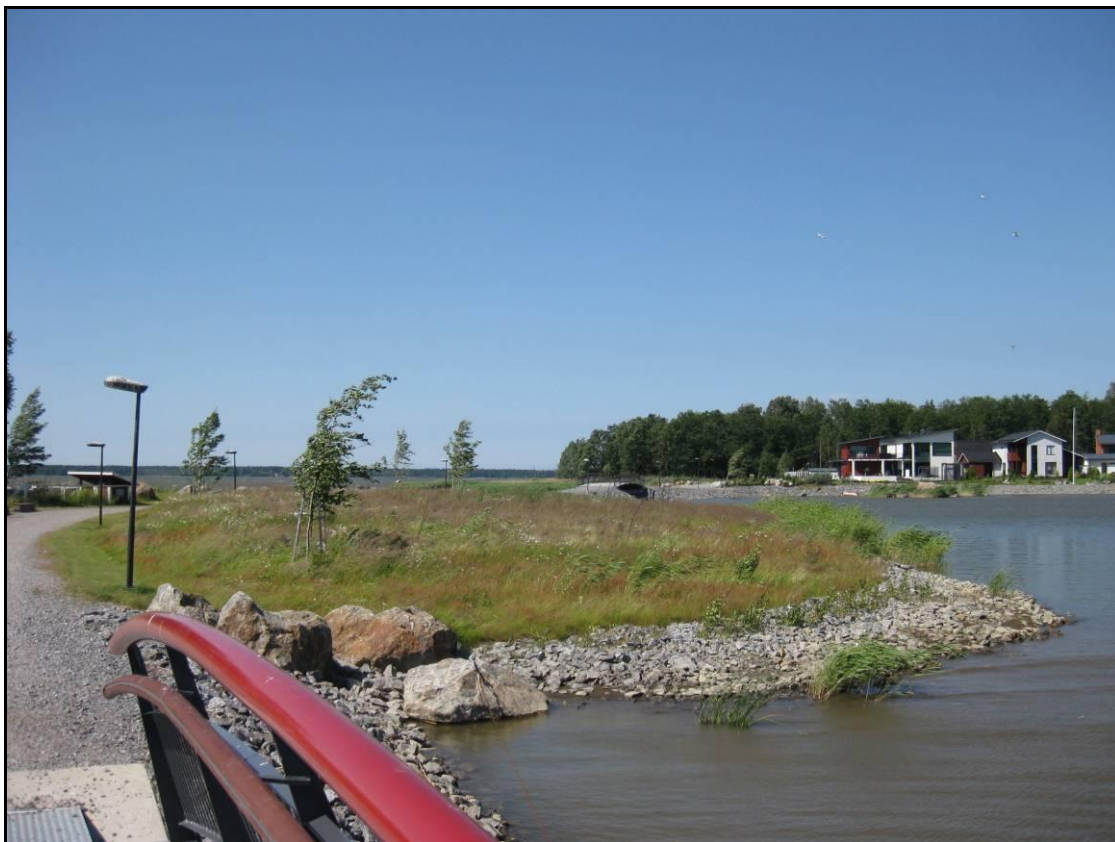
Kuva 29. Vaasan Suvilahden asuntomessualueen tekosaarien rakentamisessa on käytetty hyväksi myös alueen ruoppausmassoja (Joonas Aromaa).
