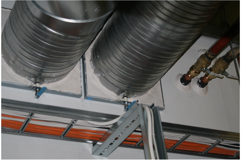
Kuva 22. IV-konehuoneen läpimenojen palokatkokittauksia ja kaapelihylly, Codel.
