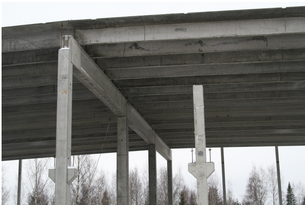
Kuva 2. Pilari-palkki-runko ja TT-laatta, Meiramitie. (tammikuu 2009)
