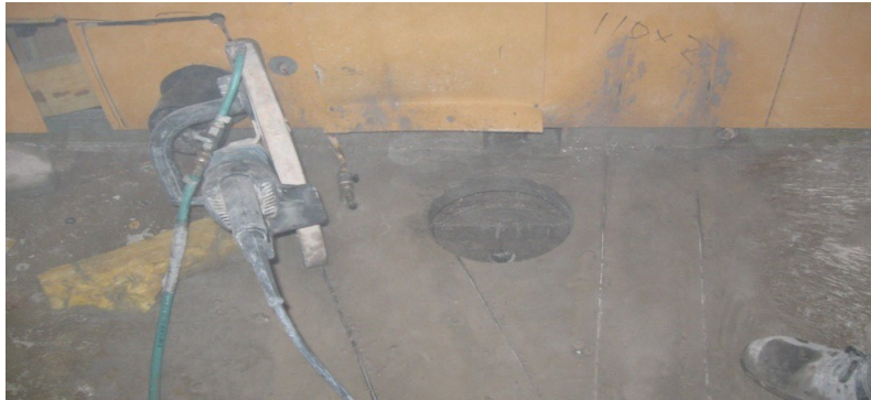
Kuvio 10: Lattian aukaisu putkiasennuksia varten (Kuva: Risto Birkman)
