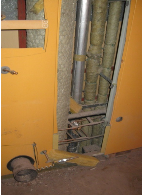
Kuvio 7: Seinää on aukaistu putkiasennuksia varten (Kuva: Risto Birkman)
