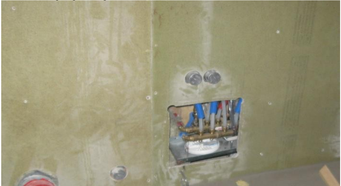
Kuvio 4: Peltiseinän eteen asennettua märkätilalevyä
