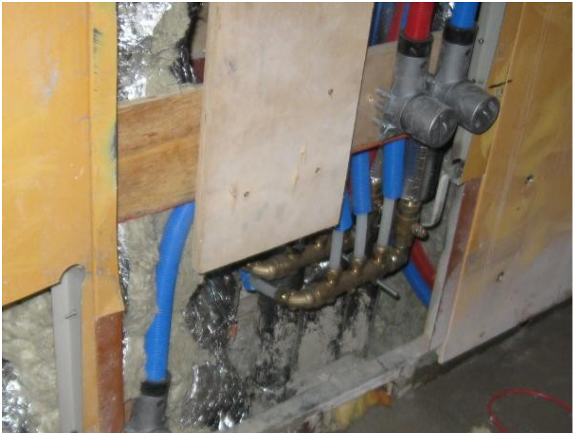
Kuvio 2: vanerilevy varmistaa kylpyhuonekalusteiden kunnollisen kiinnityksen.
