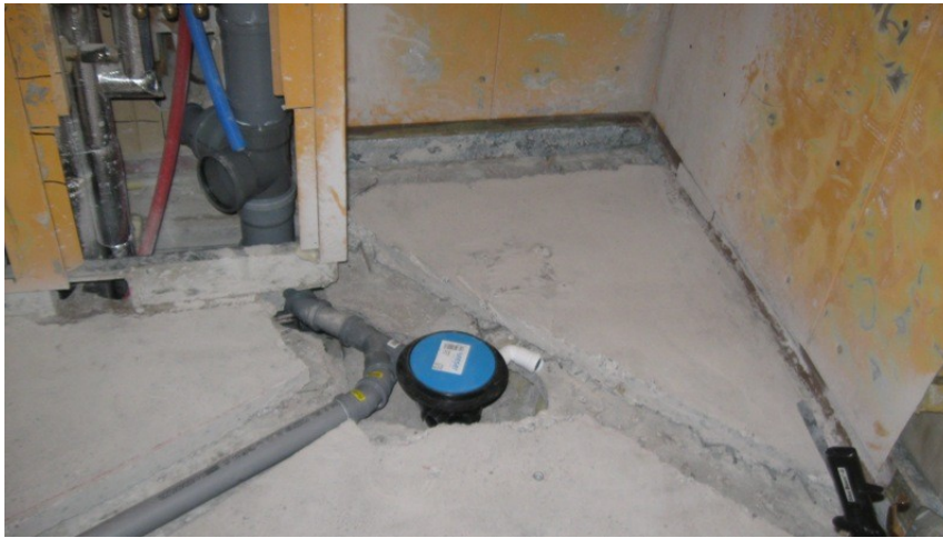
Kuvio 11: Putkiasennuksia (Kuva: Risto Birkman)
