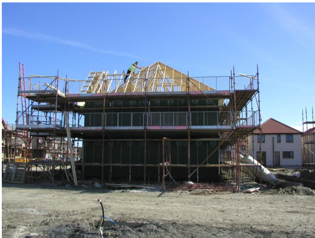
Kuva 3. telineet rakennettu rakennuksen ympärille. (Hannu Kauranen PTV-kurssi 2018)
