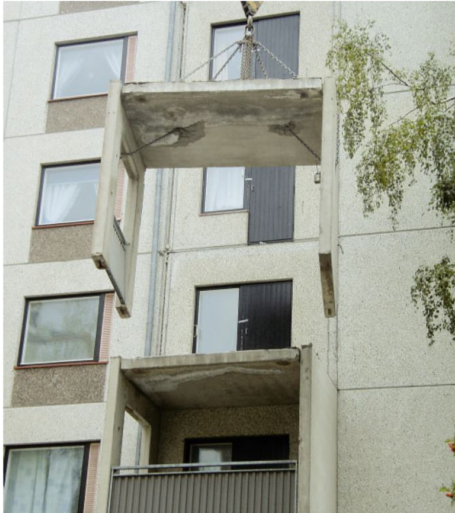
Kuva 3 elementtirakenteisen parveketornin purkamista koneellisesti.
