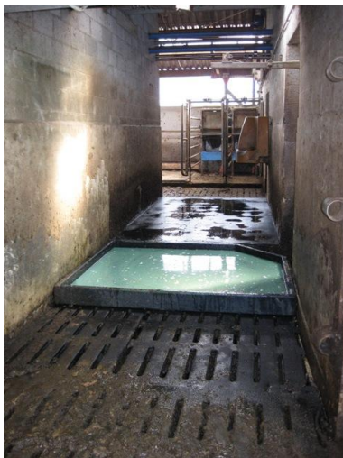
Kuva 14. Sorkkakylpyallas sijoitettuna poikkikäytävälle.
