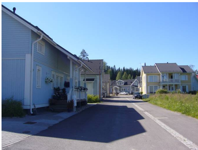
KUVIO 2. Kuva on Kariston kaupunginosasta, missä katualueet ovat kapeita ja rakennukset kiinni katualueessa.
