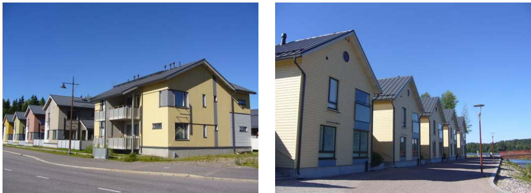
KUVIO 6. Kariston pääteemana on puurakentaminen.
