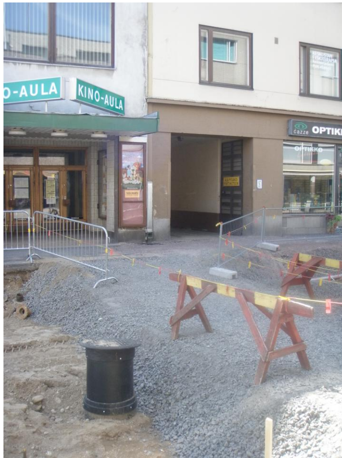
Kuva 1. Työmaan aikana jalankulkijoita varten tehty ylitys
