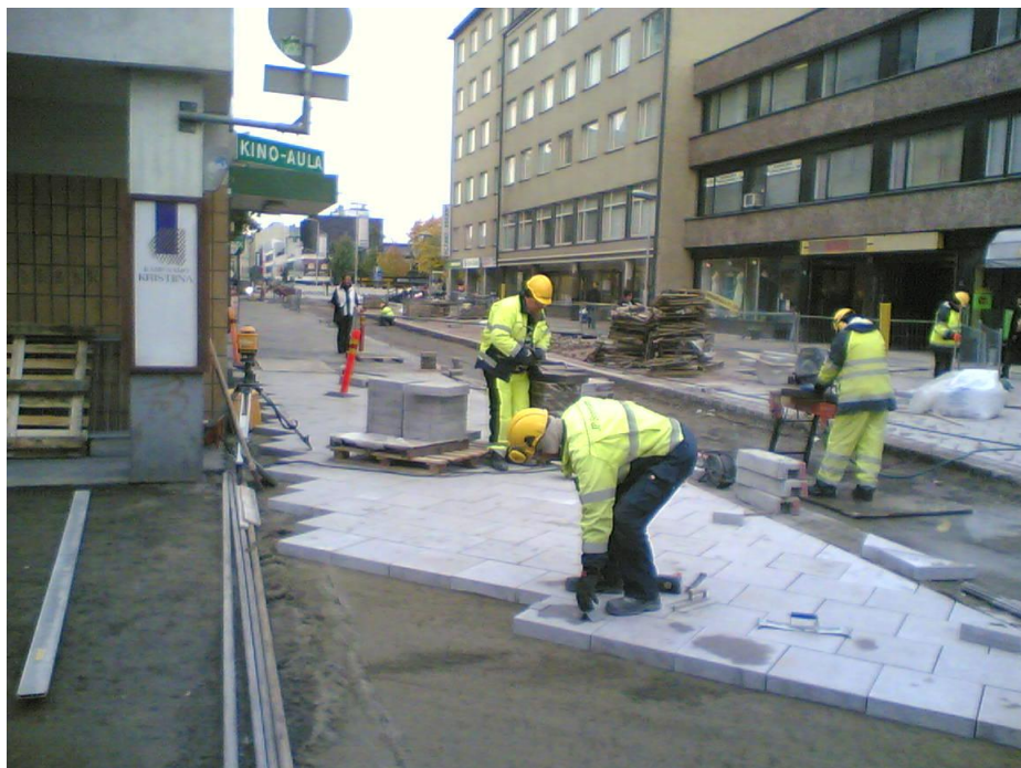
Kuva 9. Graniittilaattojen asennusta
