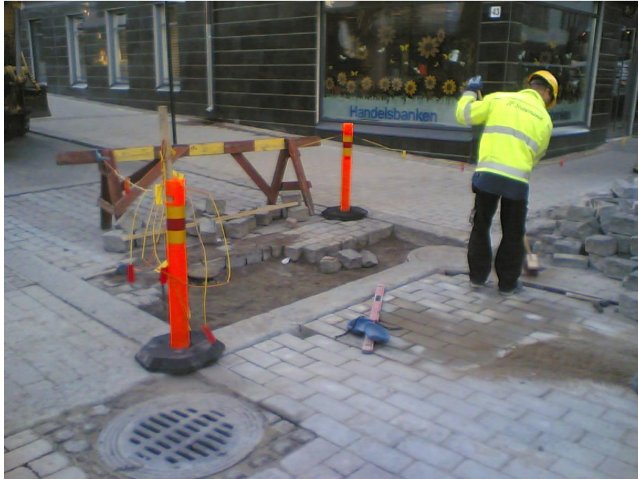
Kuva 8. Kivien asennusta
