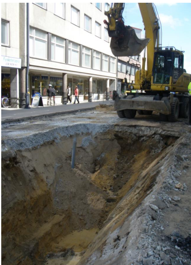
Kuva 2. Vesijohdon sujutusta varten kaivetaan kuoppaa
