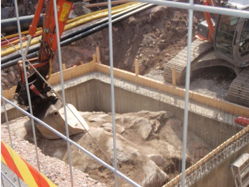
Kuva 4. Putoamissuojaus on oleellinen osa rakennustyömaiden työturvallisuutta (67.)
