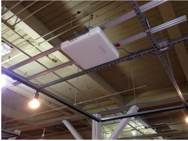
Kuvio 13. RFID-aluelukija kattoon kiinnitettynä (Cook 2014)
