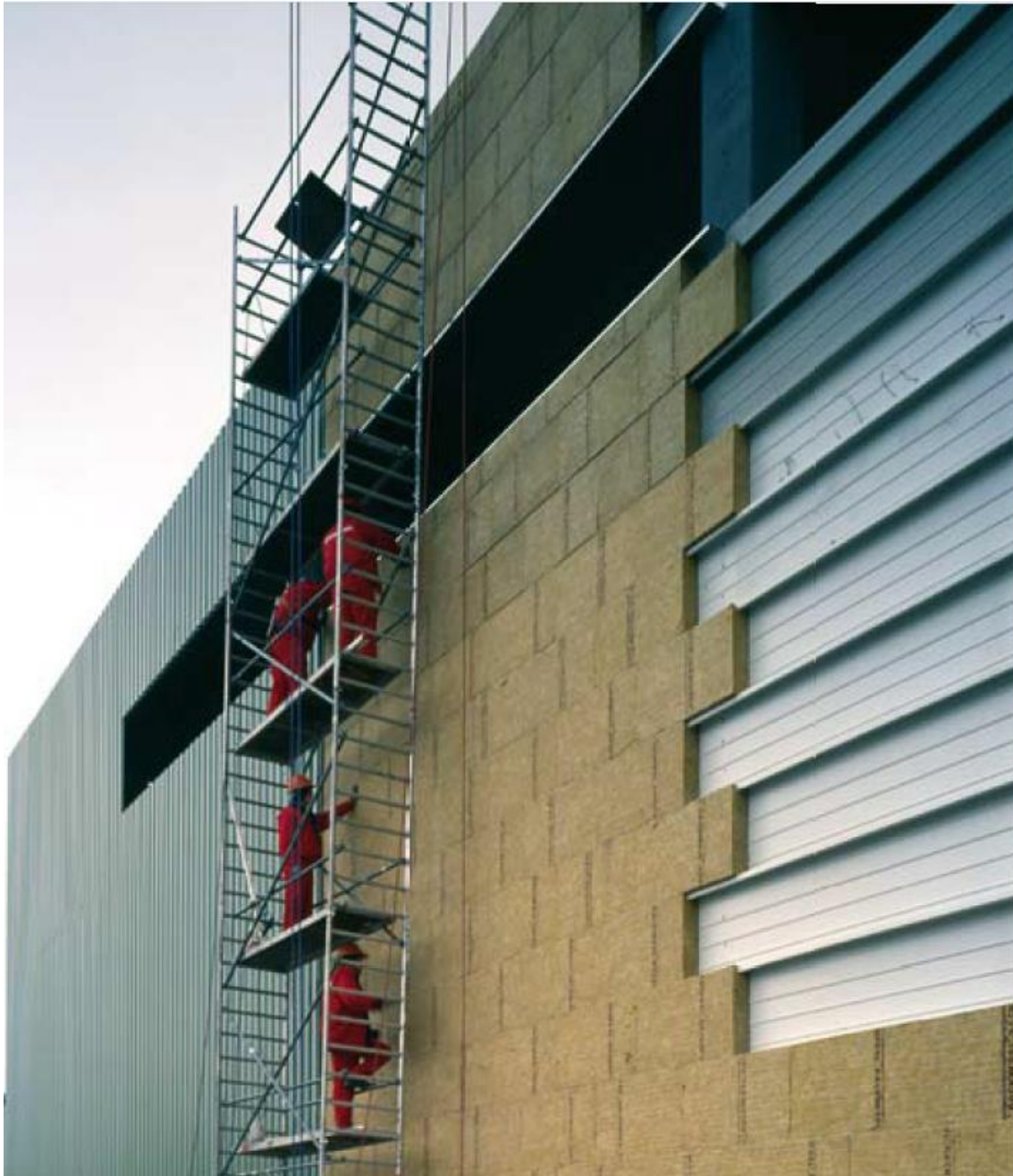
KUVA 4. Kasettiseinän villojen ja ulkoverhouksen asentamista (10, s. 11)
