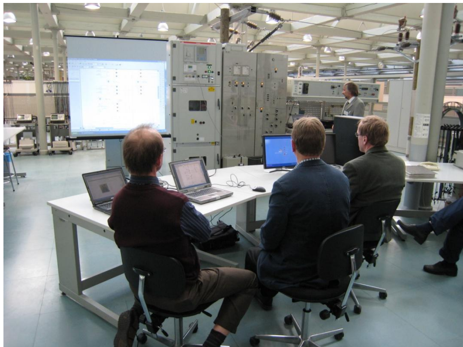
Kuva 37. Sähkölaitoksen valvomon toiminnan oppimisympäristö, jossa valvomo-ohjelmistot, keskijännitekojeisto ja kauko-ohjattava erotinasema (VAMK). Kuva on otettu sähköalan amk-opettajien koulutuspäivillä Vaasassa
