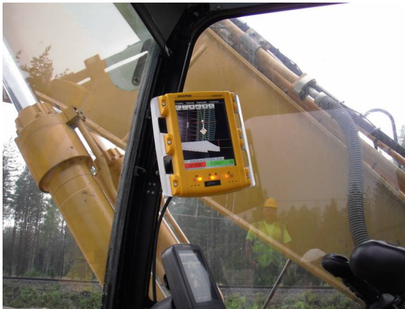
Kuva 22 Novatronin päätelaite, josta selviää missä ja mitä tehdään
