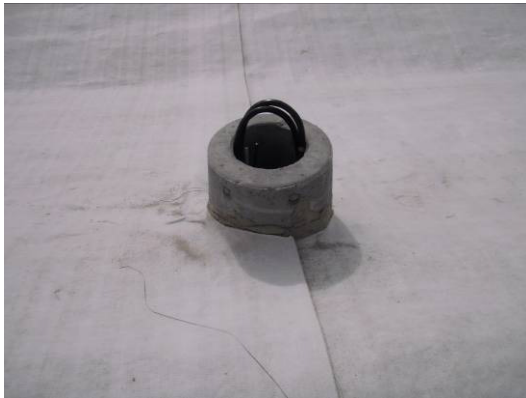
Kuva 8 Valopylvään anturan läpivienti
