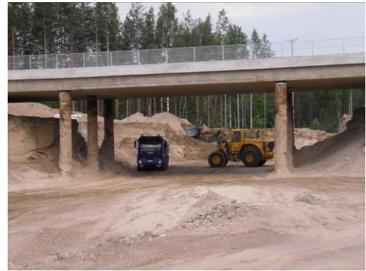
Kuva 13 KUP 25 kuormaa suojaver-houkseen käytettävää "kitkamaata"
