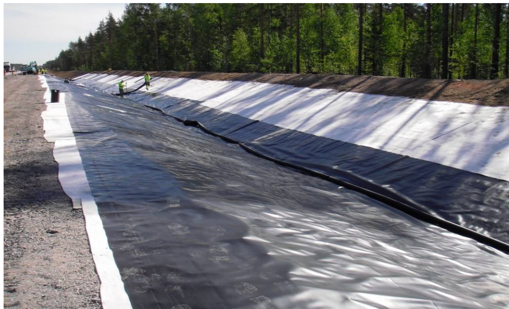
Kuva 4 Bentoniittimaton ja ohutmuovin yhdistelmä rakenne
