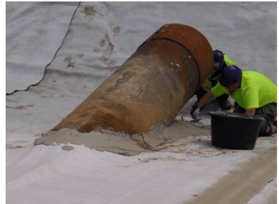
Kuva 10 Rummun läpiviennin tiivistäminen bentoniittipastalla
