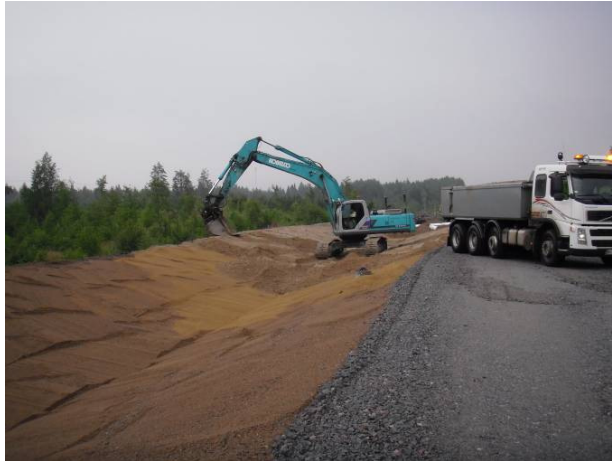
Kuva 6 Suojaverhouksen tekoa suojausrakenteen päällä
