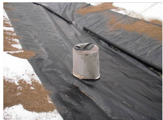
Kuva 11 Valmis valopylvään anturan läpivienti
