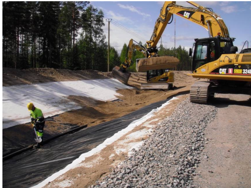
Kuva 14 Kkht 25 ja 14 tekemässä suoja- ja salaojakerrosta
