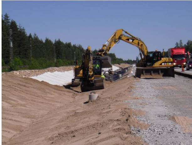
Kuva 5 Suoja- ja salaojakerroksen tekoa
