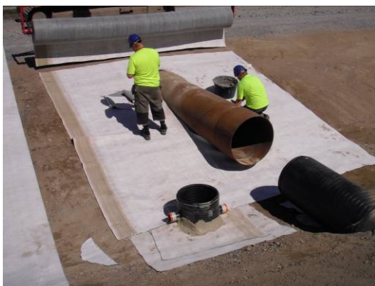
Kuva 9 Rummun läpiviennin tekoa
