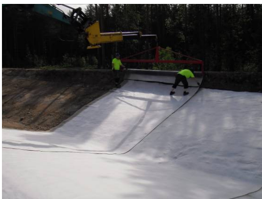
Kuva 19 Bentoniittimaton levittäminen on helppoa kun on oikeanlaiset työvälineet
