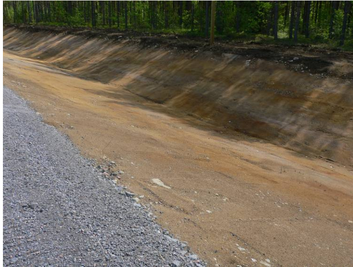
Kuva 2 Tasoitettu ja tiivistetty asennuspohja
