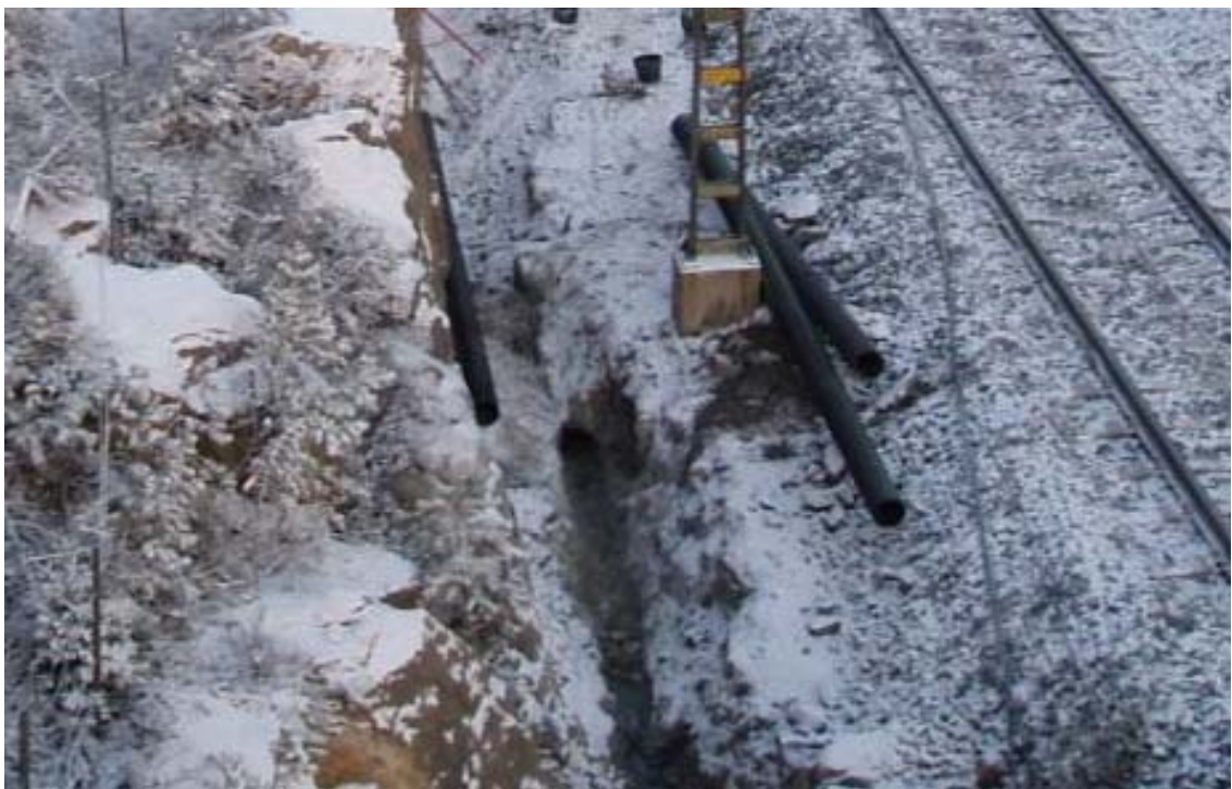
Kuva 20: Poraus sähköratapylväsperustuksen ohi
