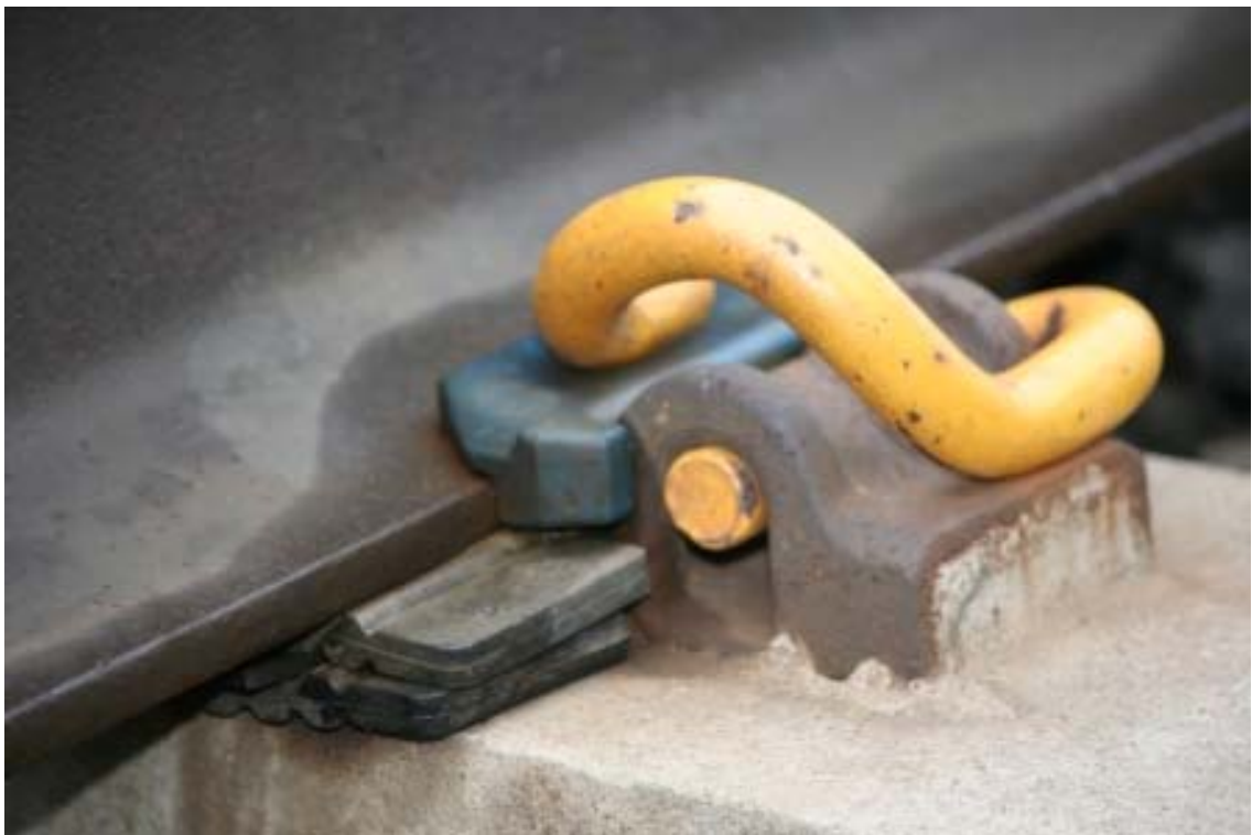
Kuva 5: Pandrol -kiinnitteisen betonipölkkyraiteen routakiilausta välilevyjä lisäämällä
