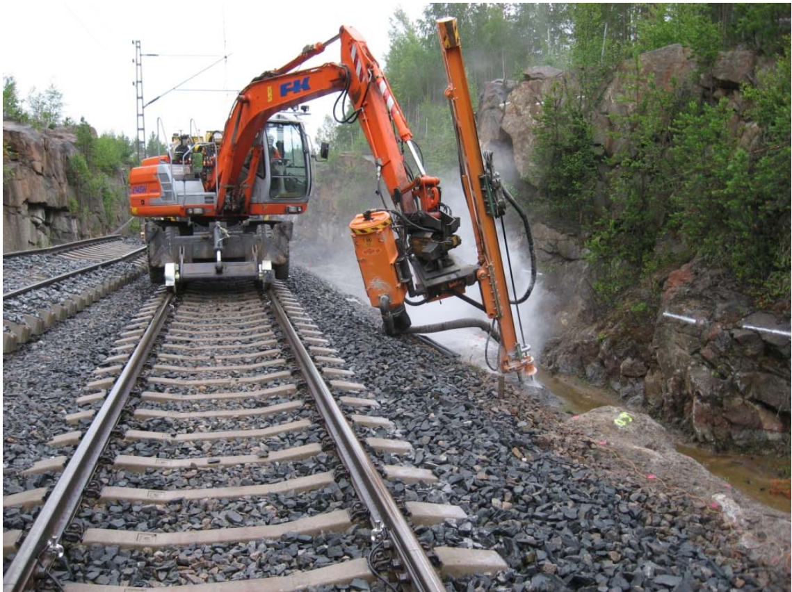
Kuva 17: Panosreikien porausta poralaitteella varustetulla kiskoilla kulkevalla kaivurilla
