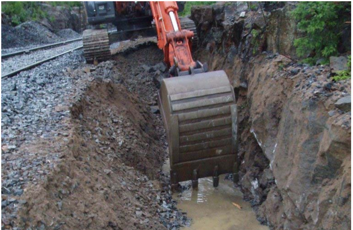
Kuva 18: Salaojalle louhitun kanaalin auki kaivua
