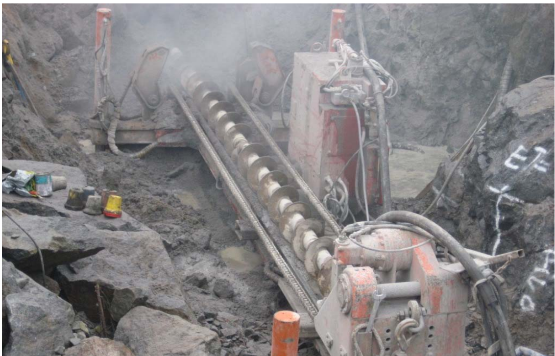
Kuva 24: Vaakaporauskalustolla porataan kallioon reikää salaojaa varten
