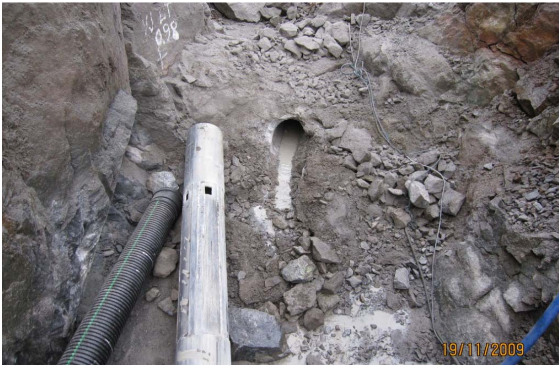
Kuva 25: Reiän ulostuloaukko ja ohjainputki
