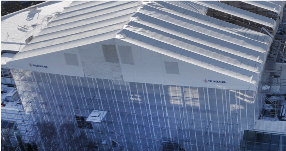
Kuva 11. KH XL sääsuoja käytössä työmaalla (Telinekataja 2019)
