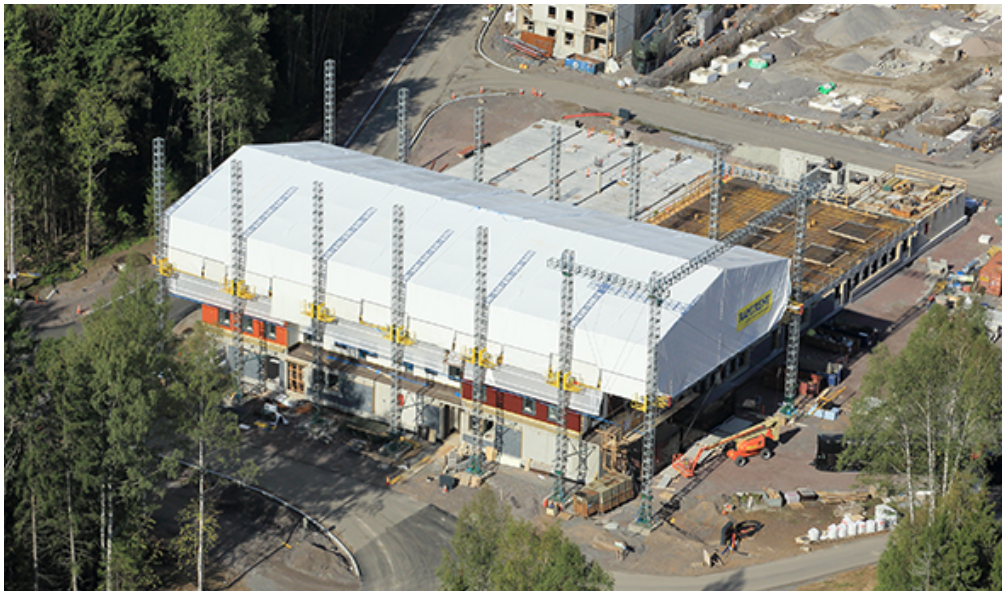
Kuva 10. RamiTower säesuojahalli työmaakäytössä (Ramirent 2019)
