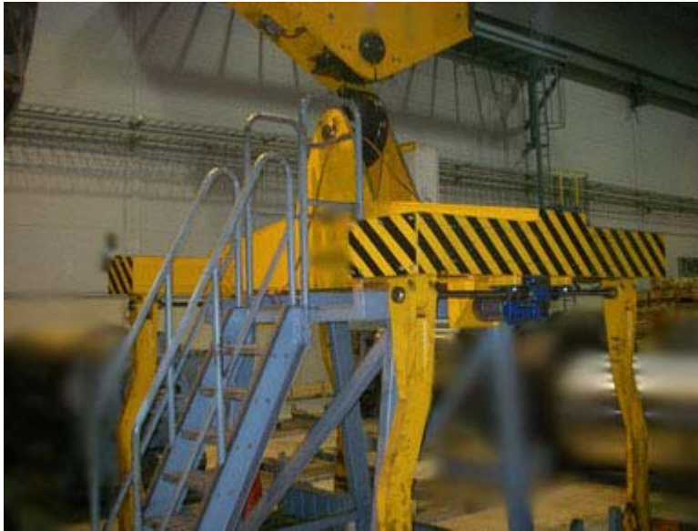
Kuva 13. Nosto-orssi säilytystason päällä ja kiinnitettynä siltanosturiin
