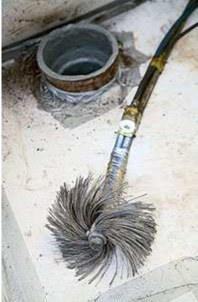
Kuva 16. DaKKI-pinnoituksessa käytettävä erikoistyökalu [29].
