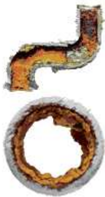
Kuva 8. Sinkityn teräspuutken sisäpuolinen korroosio [24].
