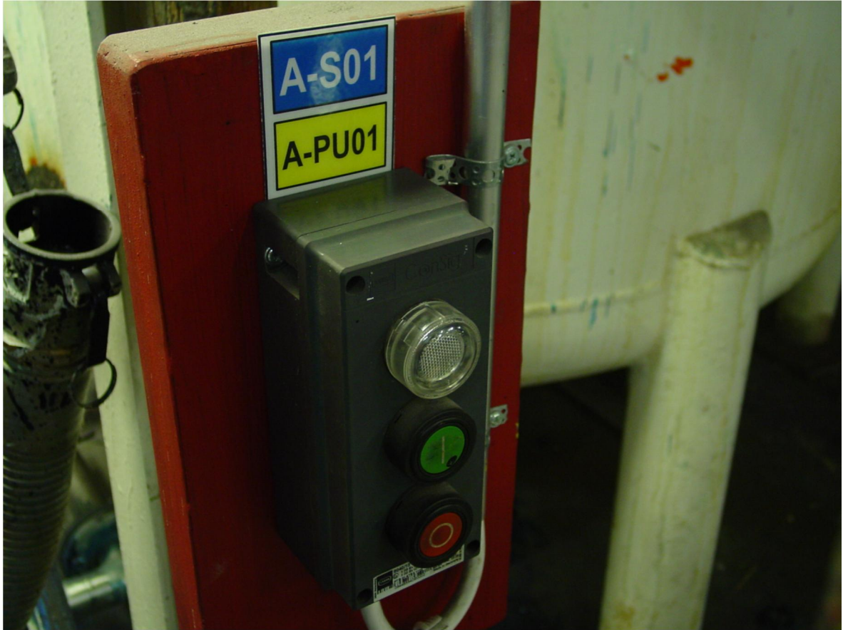
Kuva 10: Testiasennus A-hallin lattiatasolla olevalle pumppukytkimelle.
