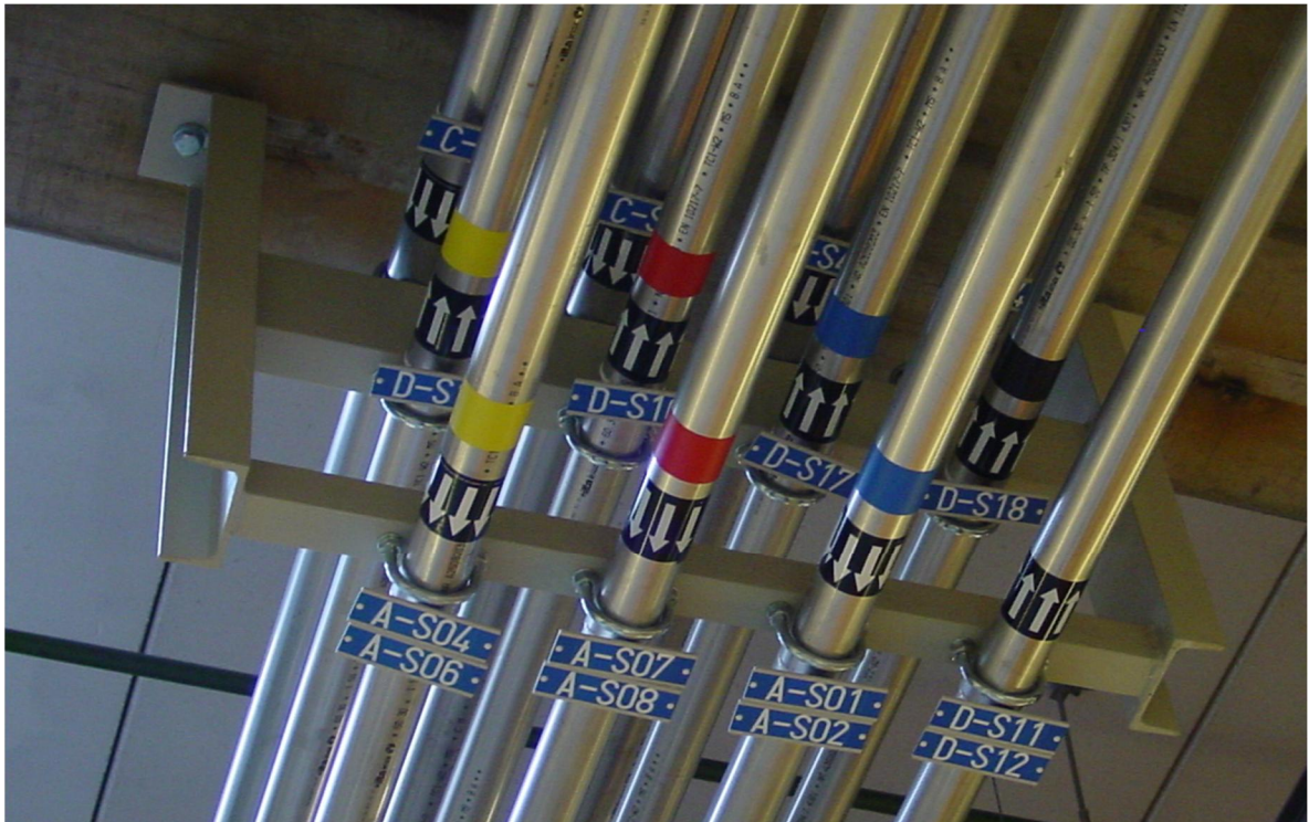
Kuva 6: Katonrajassa kulkevan putkirykelmän uudet merkinnät asennettuna.
