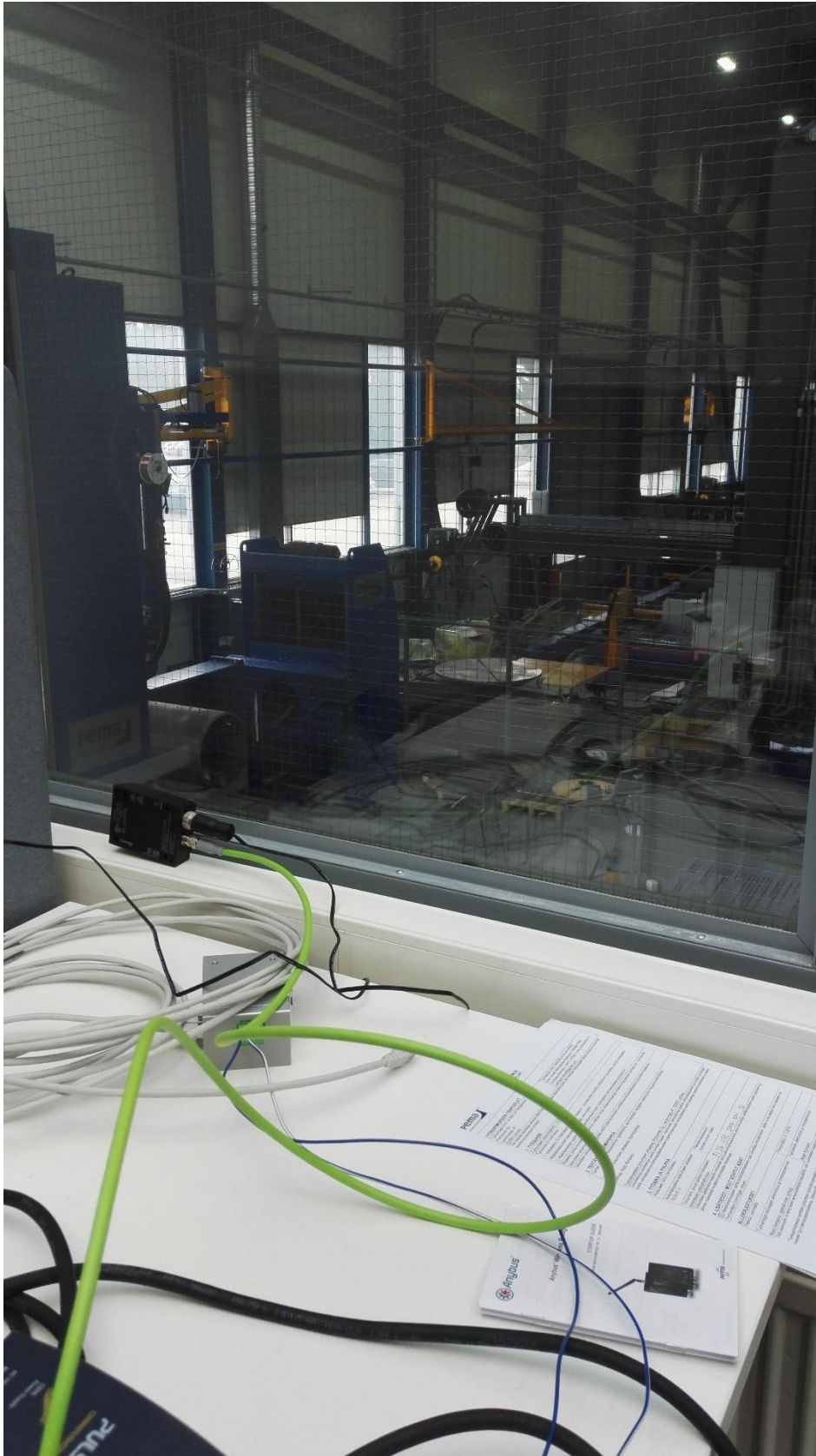
Kuva 8 Anybus Bridge kohdennettuna hallin suuntaan, missä toinen logiikka on sijoitettu.
