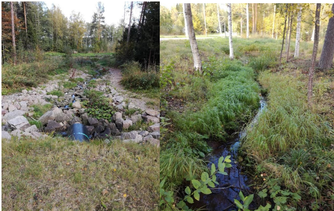
Kuva 4. Vasemmalla hyvin toteutettu porraskäytävä ja oikealla huonosti toteutettu portaaton puro (Sihvo 2018)
