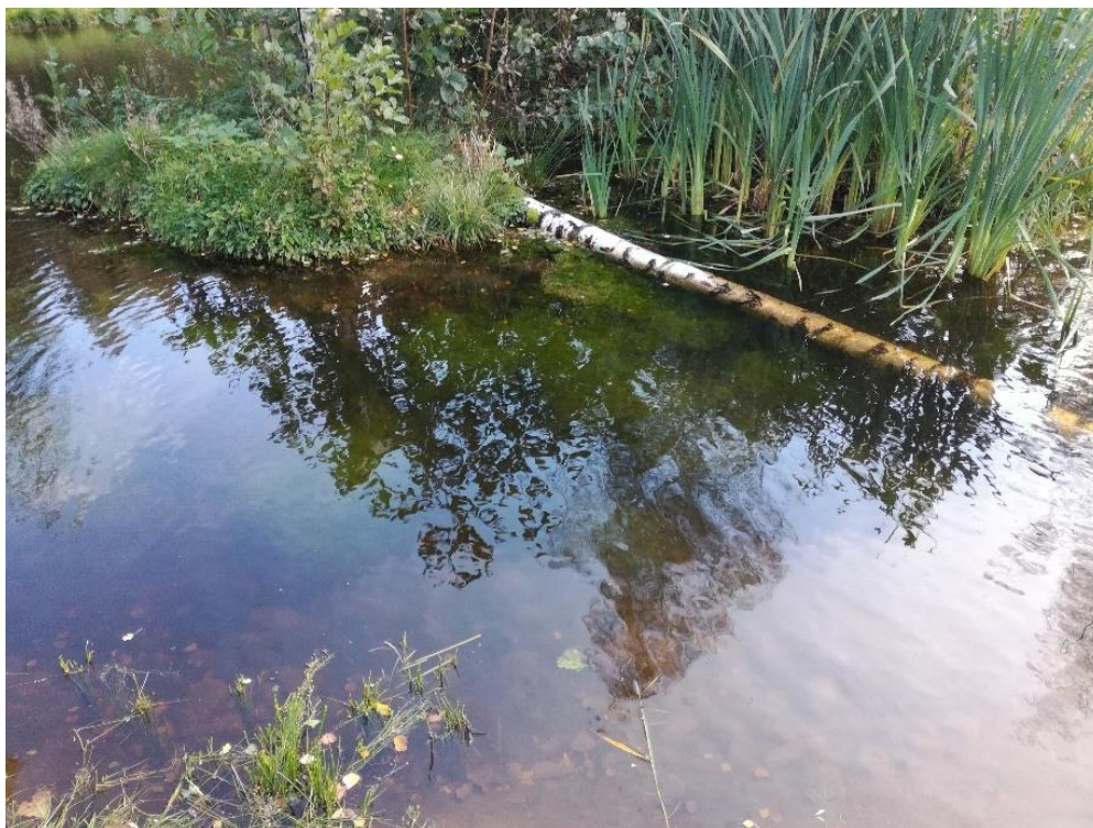
Kuva 2. Asennettu koivun runko mikrobitoiminnan ja monimuotoisuuden lisäämiseksi allasrakenteessa. (Sihvo 2018)
