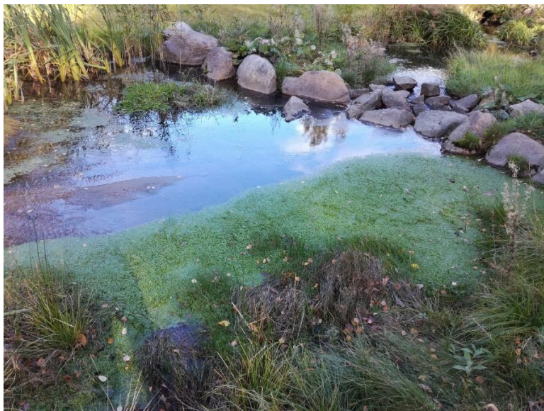
Kuva 6. Huonosti suunniteltu täytynyt laskeutusallas ja heikosti rakennettu pohjapato, joka on kokenut painumaa (Sihvo 2018)
