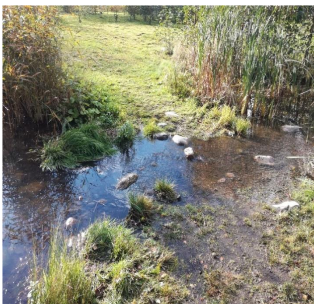
Kuva 18. Puuttuva pato ja puuttuva pengerrys (Sihvo 2018)
