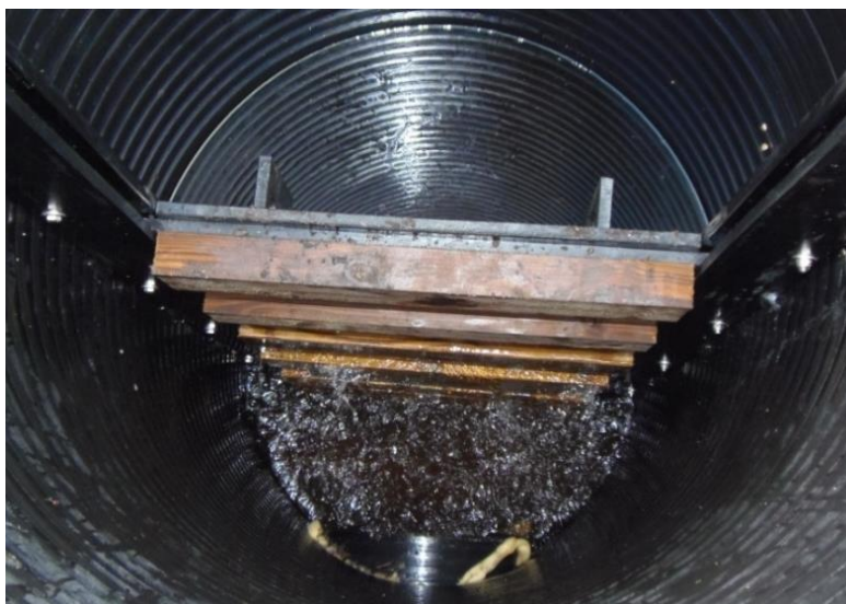
Kuva 8. Munkkikaivo, jossa keskellä ponttilankut (Kuva Alhainen, Mikko 2014)
