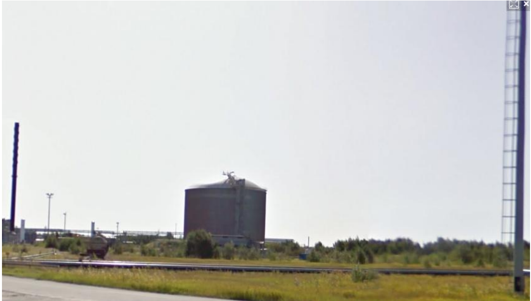
Kuva 20: Kemiran tehtaan fosforihapposäiliö.
