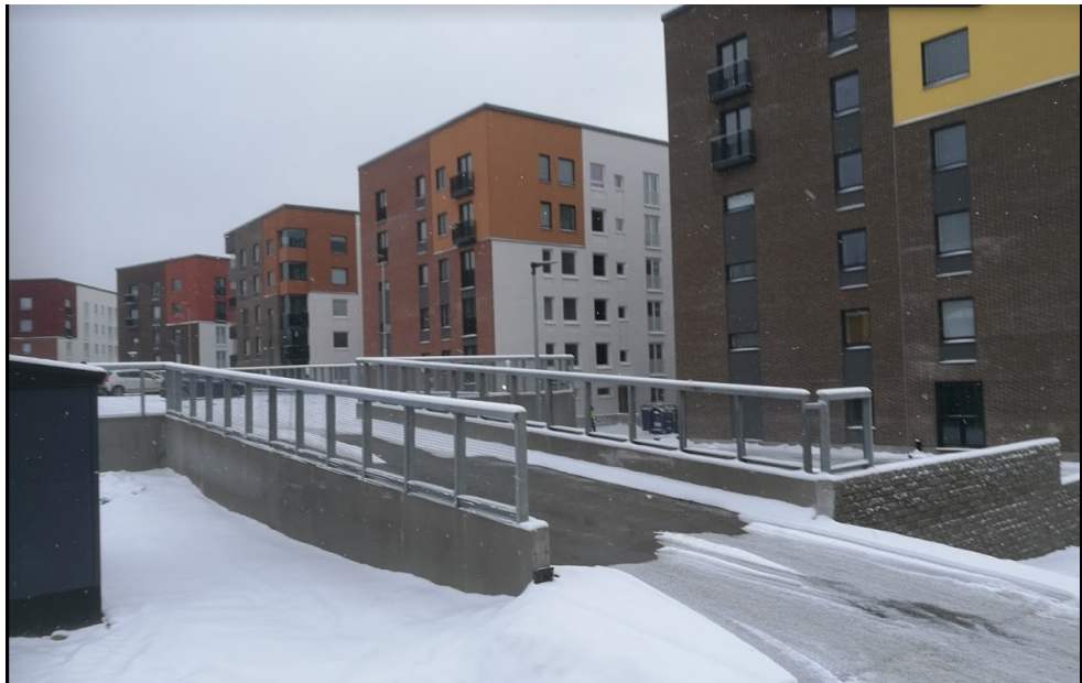
Kuva 1. Klaukkalan työmaa. (Suojalehto 2018).
