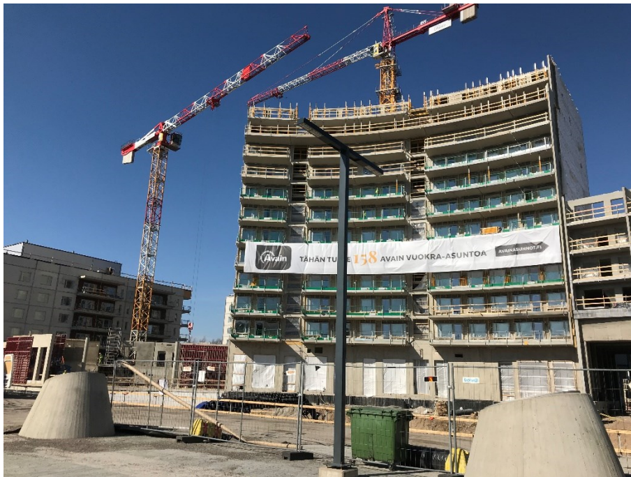
Kuva 2. Kivistön työmaa. (Suojalehto 2019).
