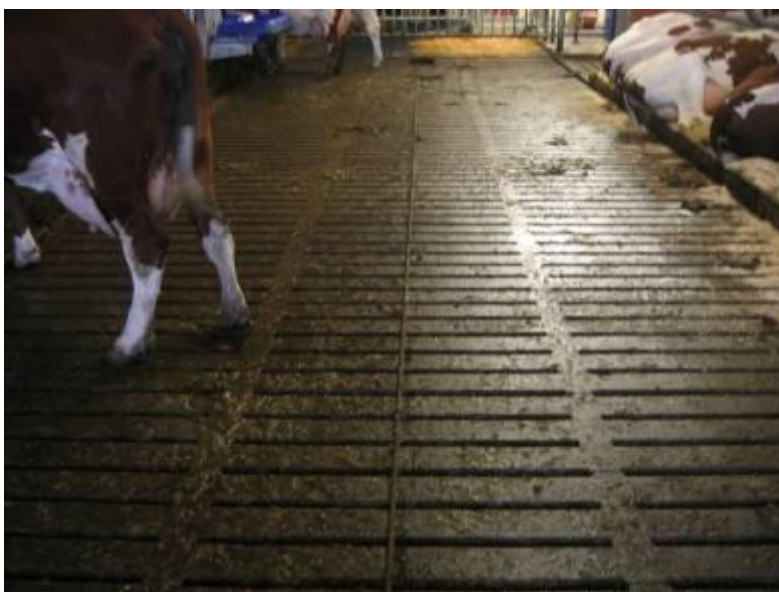
KUVA 5. Ritilälattia. Keskellä käytävää kulkee pintaraapan vaijeri.
