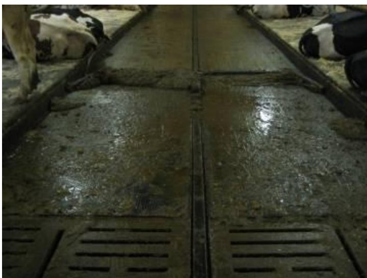
KUVA 4. Avokouru jossa on kumimatto. Raappa puhdistaa avokourun säännöllisesti tuoden lannat käytävän päädyssä olevalle ritilälle, josta lanta valuu kokoojakaivoon.
