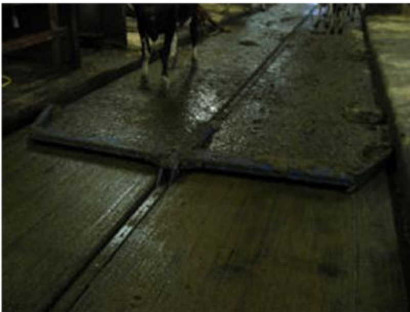
KUVA 13. Automaattinen raappa puhdistaa käytävää.
