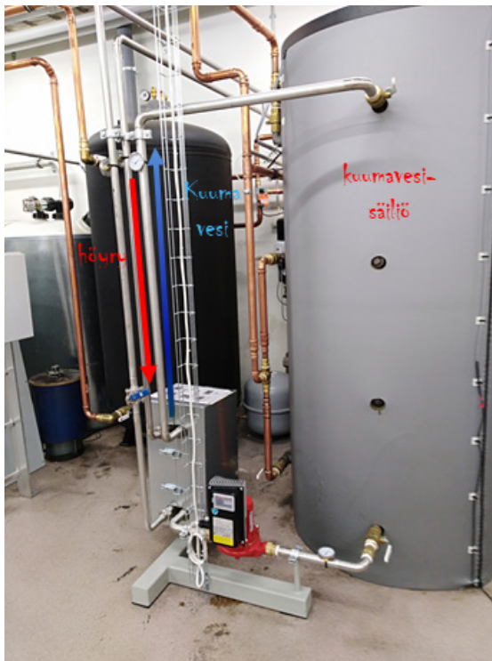
Kuva 20. Adsorptiokoneen kuumavesisäiliö ja sen höyry- ja vesilämmityspiirit, joihin ovat kytkettyinä lämmönsiirrin (30 kW) ja kiertovesipumppu (80 W).
