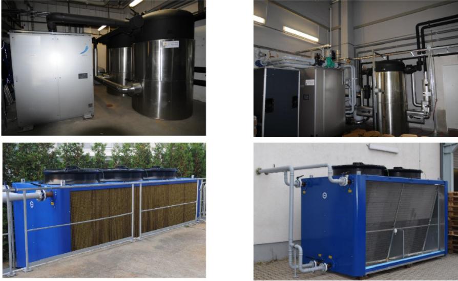
Kuva 16. Järjestelmän esimerkkikokoonpanoja: 175 kW:n absorptiokone vasemmalla ja 70 kW:n oikealla. Koneissa on perinteisen kompressorijärjestelmän tapaan höyrystin, lauhdutin ja paisunta-venttiili. Mekaaninen kompressor on korvattu termisellä kompressorilla. (Kuva: SolarNext 2017.)
