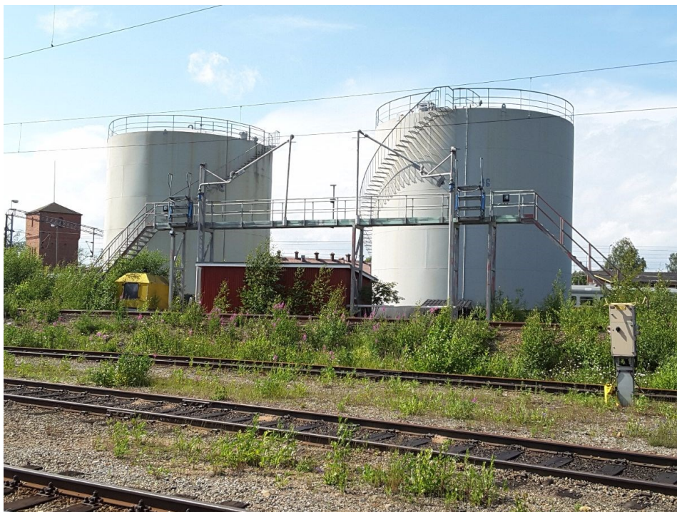
Kuva 7. Vanhat polttoaineen varastosäiliöt Joensuussa on puhdistettu ja tyhjennetty odottamaan purkamista. Aikoinaan näihin kahteen säiliöön mahtui yhteensä 2000 m 3 polttoainetta.
