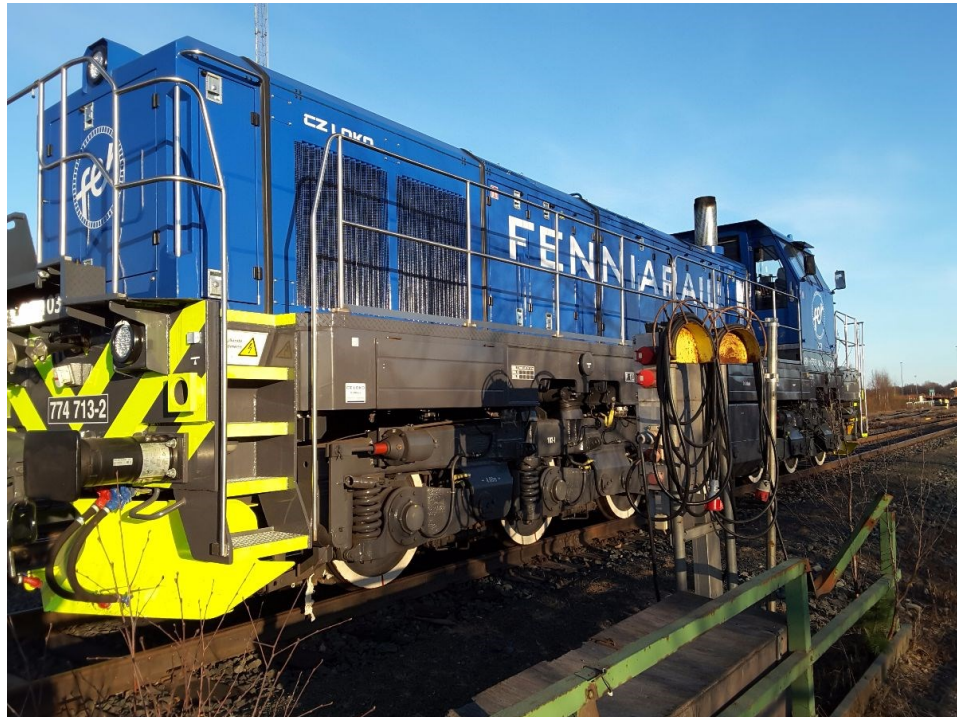
Kuva 14. Tyypillinen käyttökohde nykypäivänä 400 V -pistorasiakeskukselle on veturin liittäminen ulkoverkkoon. Torniossa raiteella 721 sijaitsevasta keskuksesta löytyvät kaikki RATO 7:n edellyttämät kolmivaihepistorasiat 400V/63A, 400V/32A, 400V/16A sekä lisäksi yksivaihepistorasia 230V/16A.
