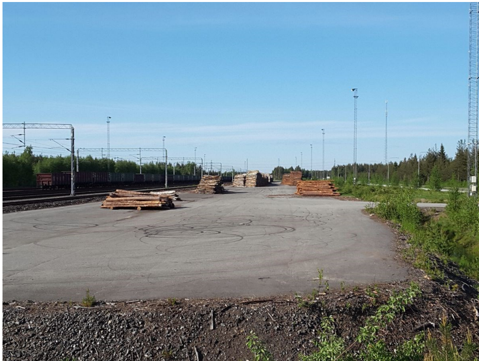
Kuva 19. Ykspihlaja väliratapihan kestopäällystetyllä kuormauskentällä kuormataan lähinnä raakapuuta rautatievaunuihin.
