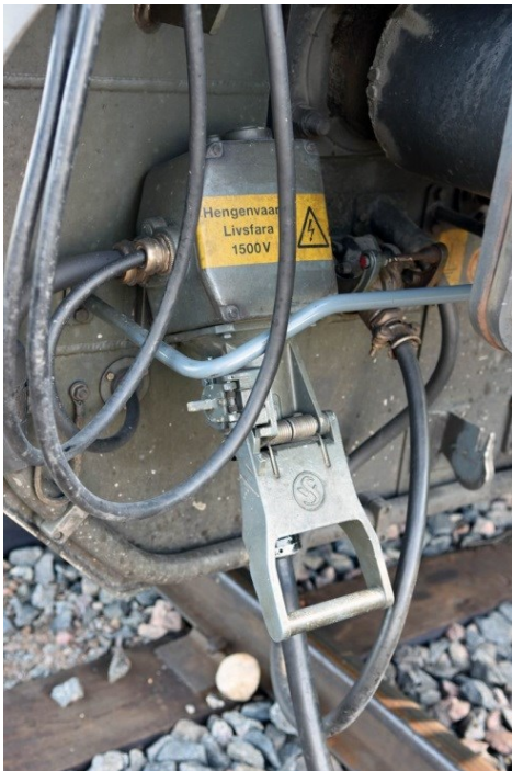
Kuva 2. 1500 V -lämmitysliitäntä vaunukaluston vastakkeeseen.
