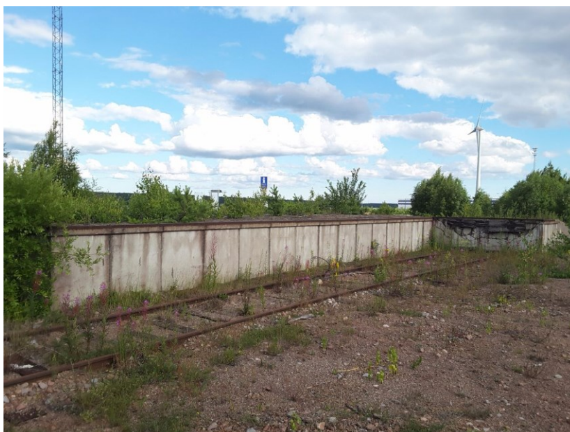
Kuva 18. Sivusta ja päädystä kuormauksen mahdollistava laituriratkaisu löytyy esimerkiksi Haminan kuormaustaituriin päätyvällä rai-teella 055. Vähäinen käyttö paljastuu mm. ruohottumisena.
