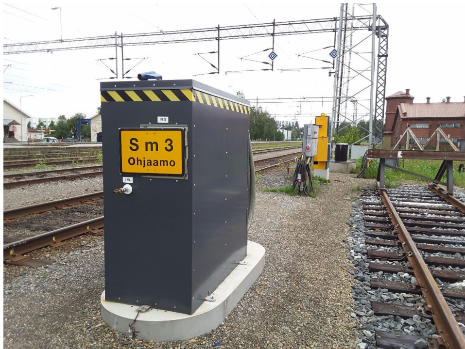
Kuva 4. Yhteiskaappi, jonka kuvasta katsottuna etupuolella sijaitsevat puhtaan veden sekä paineilman liittimet ja takapuolella jäteveden imutyhjennysletku.
