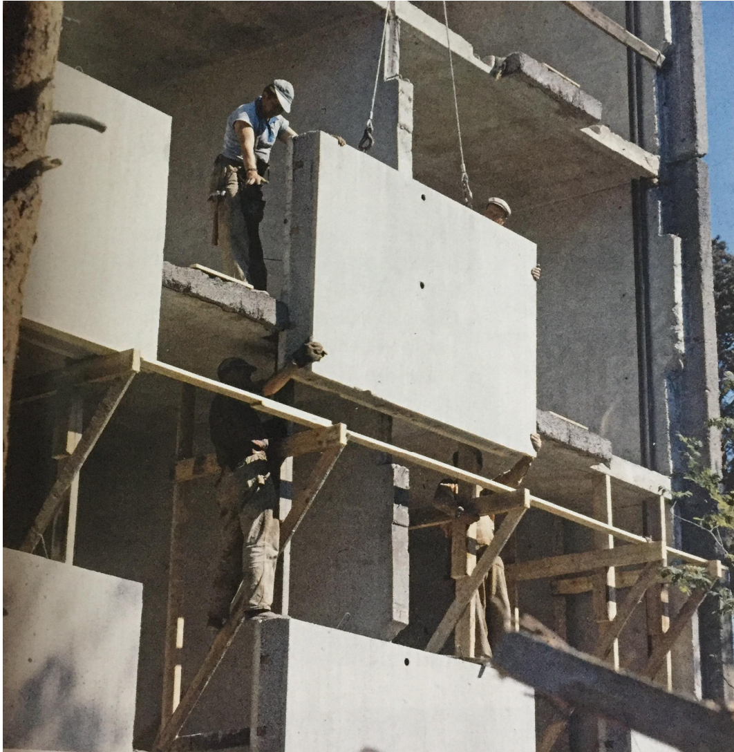
Kuva 1. Sandwich-julkisivujen asennustyötä Helsingin Pihjalamässä. (Hytönen & Seppänen 2009, s. 47)
