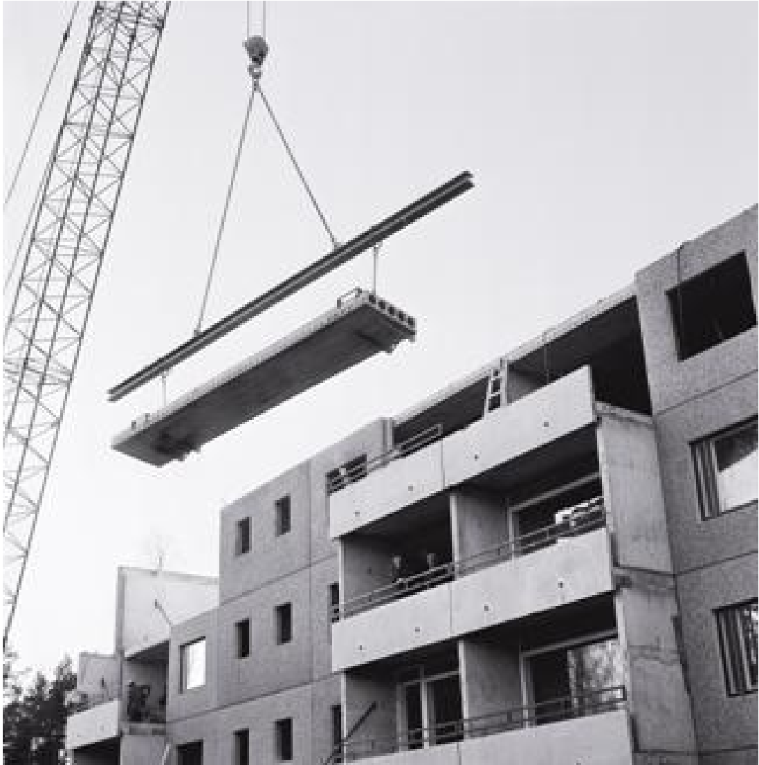
Kuva 2. Ontelolaatan asennus tyypilliseen BES- kerrostaloon. (Elementtisuunnittelu.fi)
