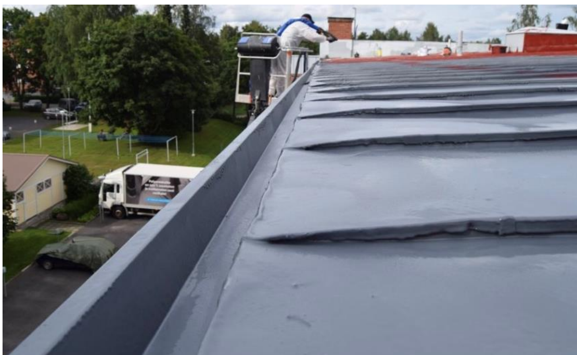
Kuva 5. Polyurealla pinnoitettu katto (Yhteistyöyrityksen oma arkisto)
