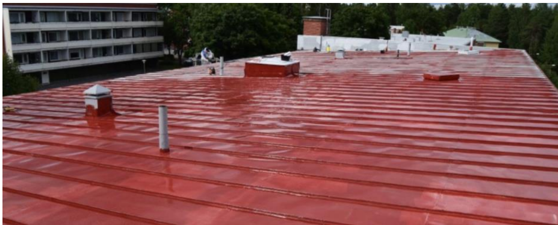
Kuva 4. Primeroitu katto (yhteistyöyrityksen oma arkisto)
