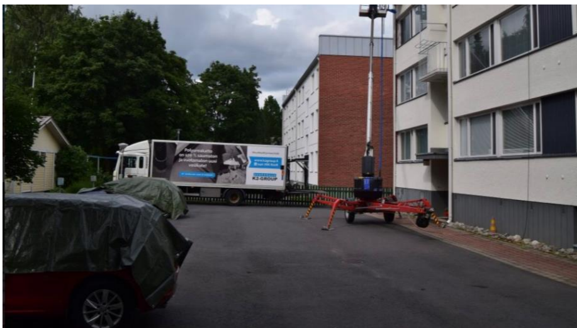
Kuva 1. Työmaan suojaus, talo odottaa myös julkisivuremonttia (Yhteistyöyrityksen oma arkisto)
