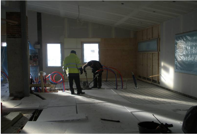
Kuva 24: Eristeet asennettu
