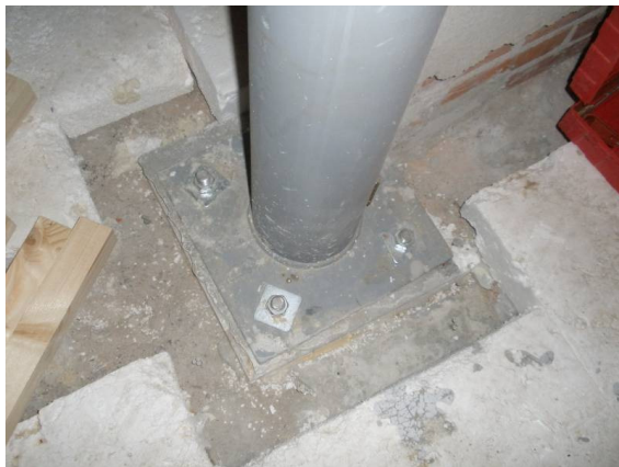
Kuva 11: Liittopilarin asennuslevyn alle tehty jälkivalu
