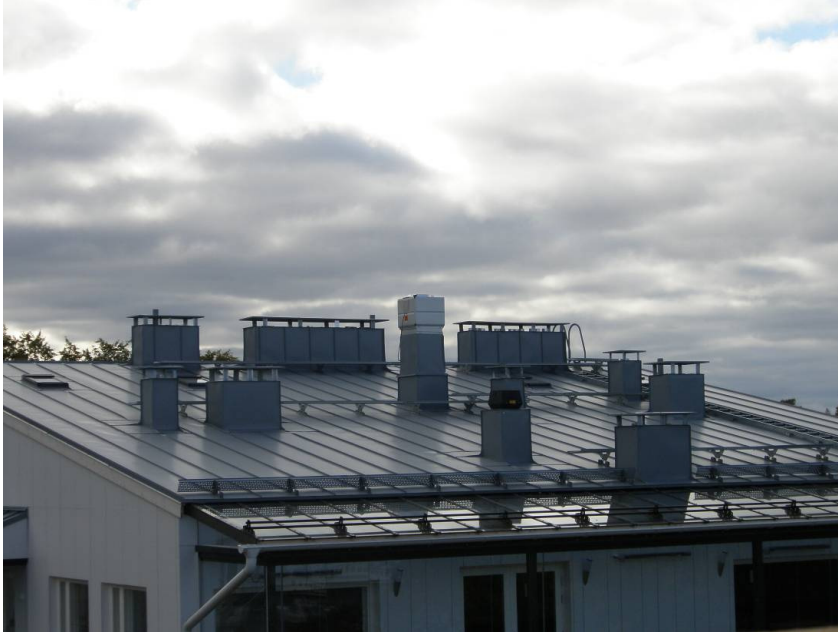
Kuva 17: Vesikaton kattoturvatuotteet
