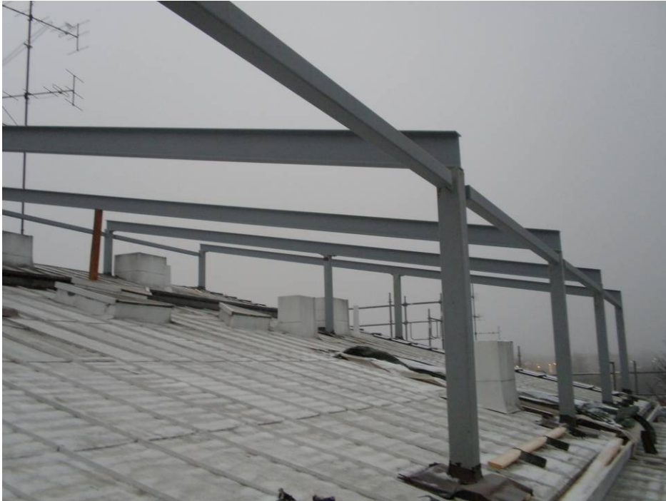
Kuva 8: Liittopilarit joiden päällä IPE-palkit. Etualalla vaakasuuntaiset putkipalkit
