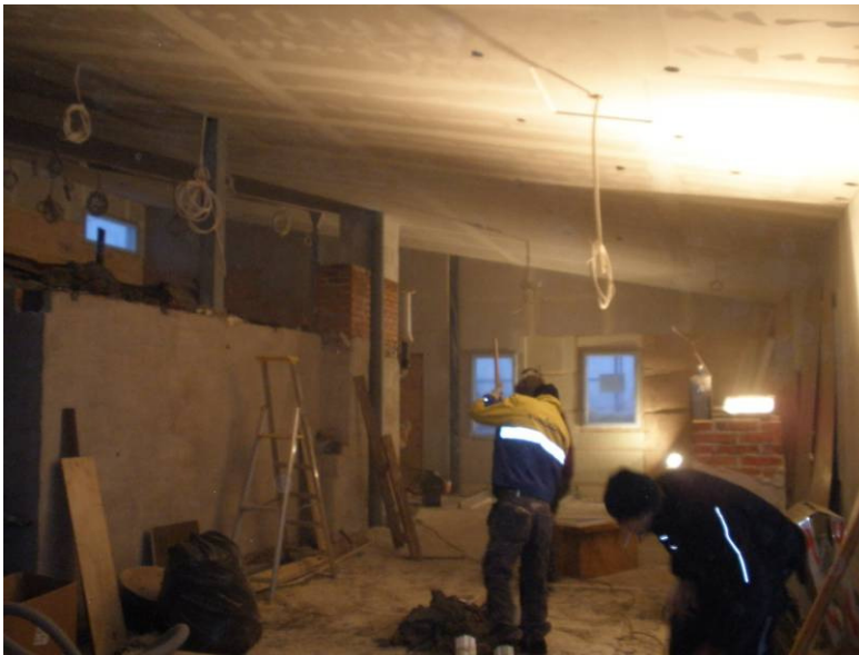
Kuva 23: Tila alkaa hahmottua, kun vanha vesikatto on purettu
