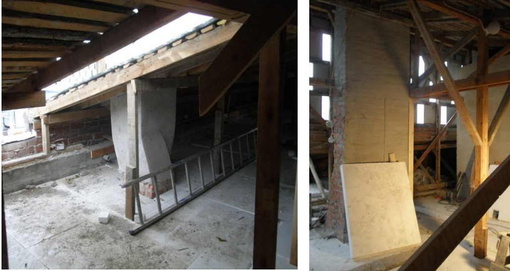
Kuvat 1 ja 2: Vanhoja muurattuja ilmastointihormeja.
