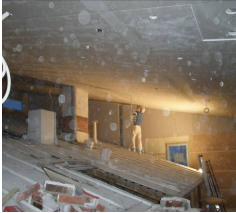
Kuva 21: Vanha vesikatto kittaustelineenä Kuva 22: Kitattu yläpohja
