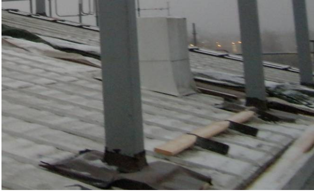
Kuva 15: Bitumikermillä tiivistetyt liitospilareiden asennusaukot
