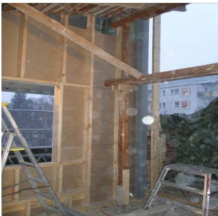
Kuvat 18 ja 19: Julkisivuseinien puurunkoja
