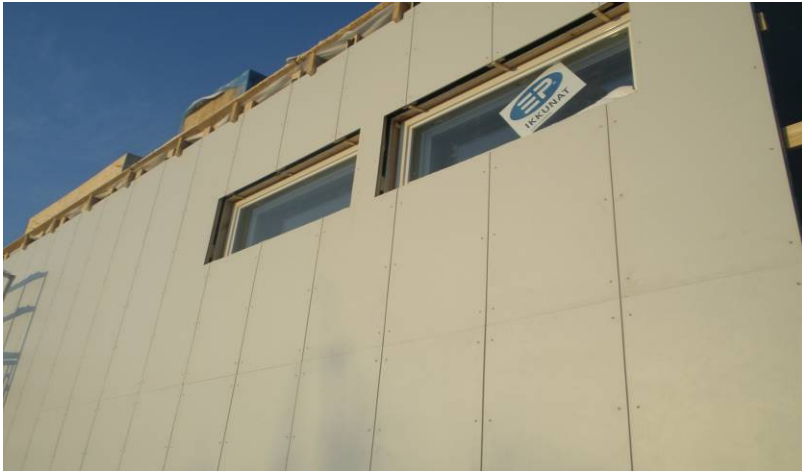
Kuva 20: Julkisivulevyt asennettu
