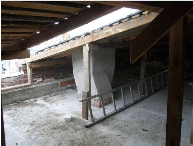
Kuva 27: Vesikattoon tehty nostoaukko
