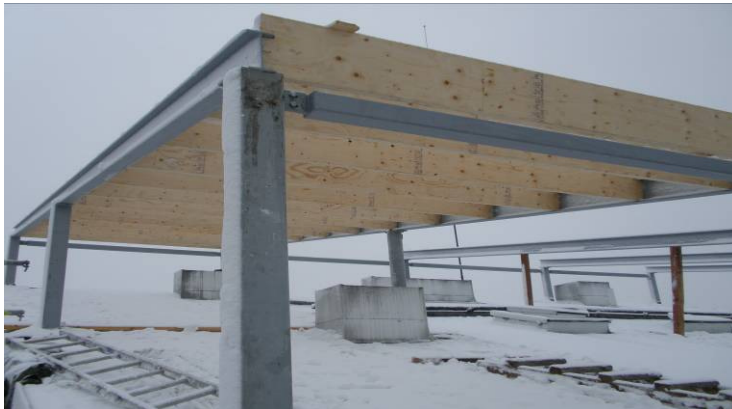
Kuva16: IPE-palkkien välissä olevat 51*300 kertopuut
