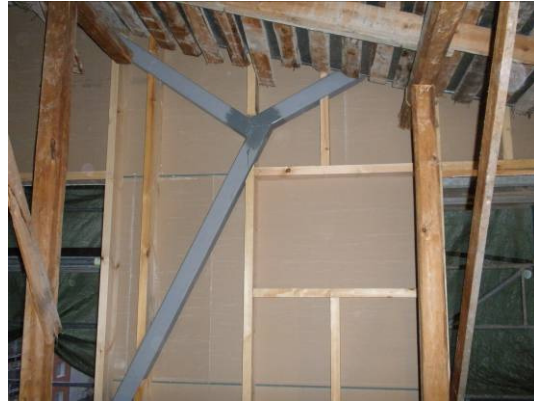
Kuvat 9 ja 10: Korroosiosuojatut vinositeiden hitsausliitokset
