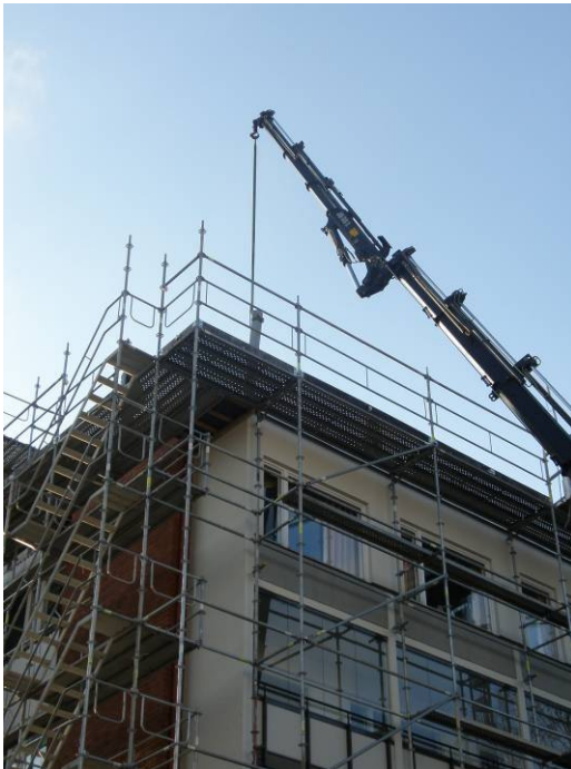
Kuvat 13: Liittopilari nostettu asennuspaikalle Kuva 14: Vesikattoon tehty asennusaukko
