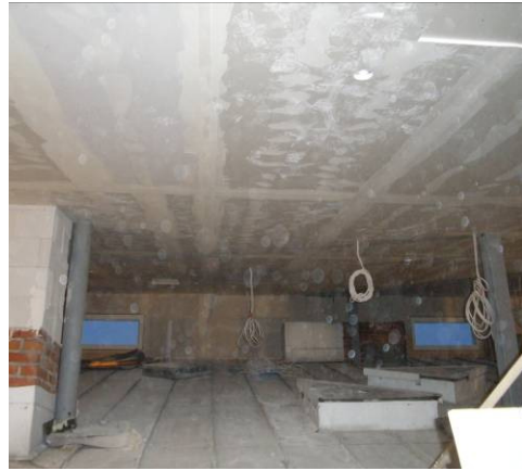
Kuva 21: Vanha vesikatto kittaustelineenä Kuva 22: Kitattu yläpohja
