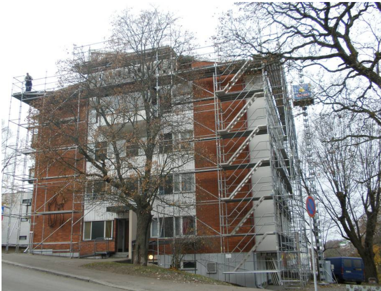
Kuva 6: Telineet itäjulkisivulta sekä telineportaat
