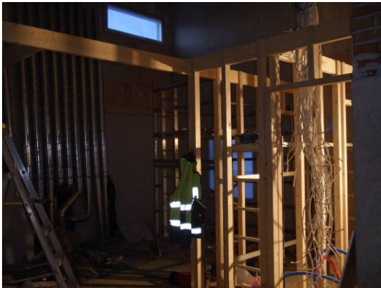
Kuva 25: Kantavia väliseinärunkoja
