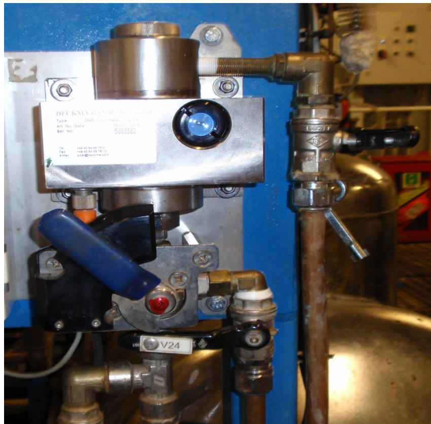
Kuva 10. OMD – 2005- yksikön mittauspää
