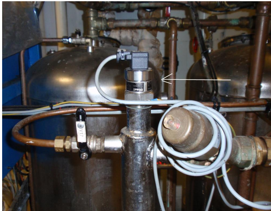
Kuva 8. Tankin T1 öljyanturi CT03
