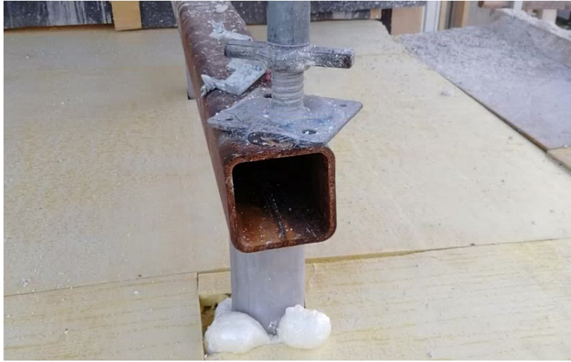
Kuva 52. Kuvakaappaus position 8 RST-jaloista ja vaakapalkista telineiden alle (27.1.2019).
