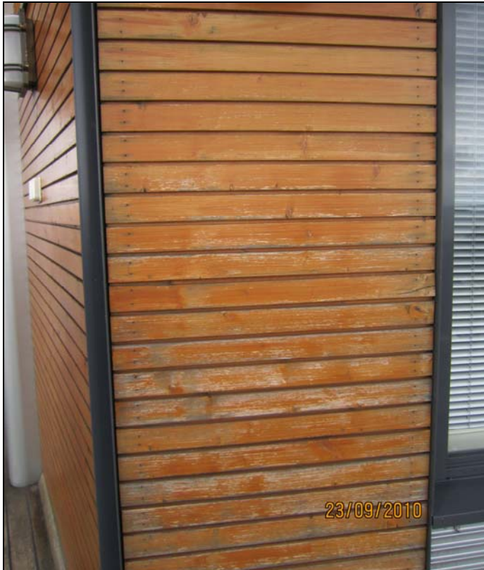
Kuva 16. Kuultokäsitelty paneelipinta kovassa rasituksessa, neljän vuoden jälkeen. [31.]
