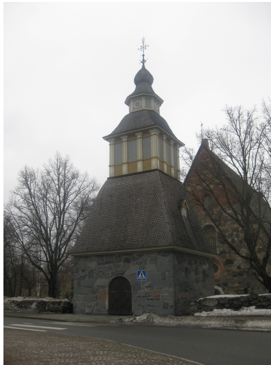
Kuva 20 Lammin kirkko ja kellotapuli ovat kylän kauneimpia rakennuksia. (Ahvonen 2010)
