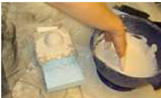
KUVA 32. Ensimmäisen kipsikerroksen levittäminen roiskimalla
