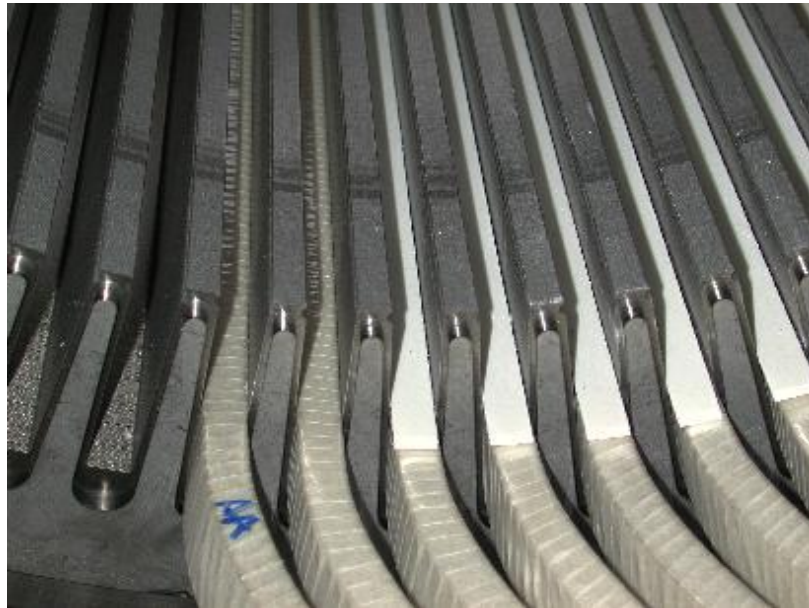
Kuva 31. Asennettuja vyyhtejä ja välitäytteitä [6]
