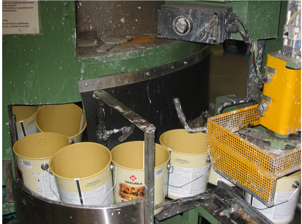
Kuva 10. Purkkikarusellin sivussa olevat aukot peitettiin äänieristeisellä kumimatolla.
