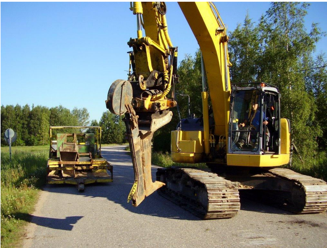
KUVA 5. Kaivinkoneen kaapeliaura (Suupohjan Seutuverkko Oy, Kuitu kotiintietopaketti 2008, 2)
