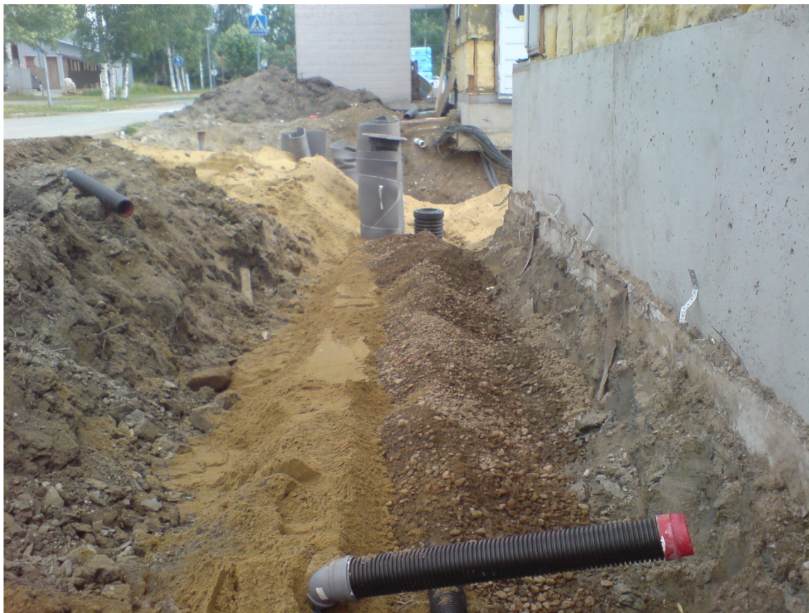
Kuva 2. Salaojaputket (oikealla), joiden päälle asennettiin salaojasoraa n. 200 mm. Sa- devesiputket (vasemmalla), joiden päällä hienoa hiekkaa n. 200 mm.
