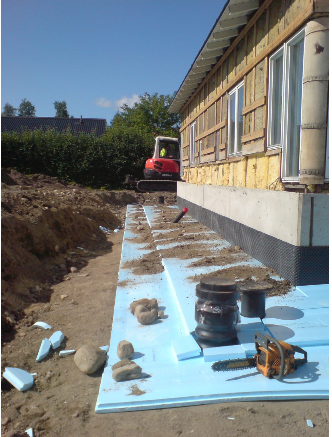
Kuva 5. Routalevyt asennettuna.
