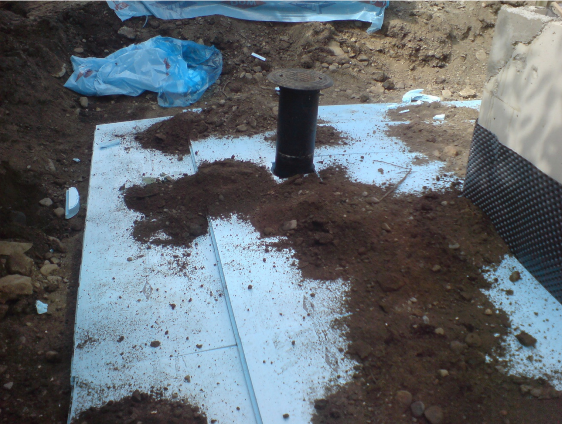
Kuva 6. Routalevyt asennettuna.
