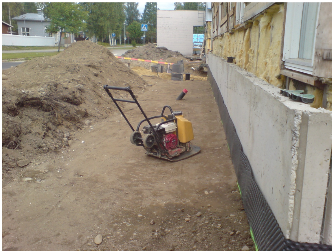
Kuva 4. Maa-aineksen tasaus ja tiivistys tärylaitteella.
