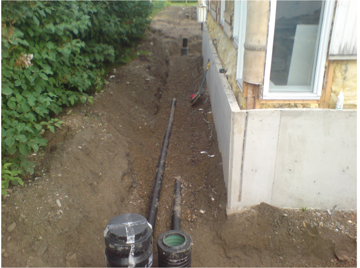
Kuva 1. Kaivannon pohjalle lisättiin n. 200 mm salaojasoraa, jonka päälle asennettiin uudet putket.
