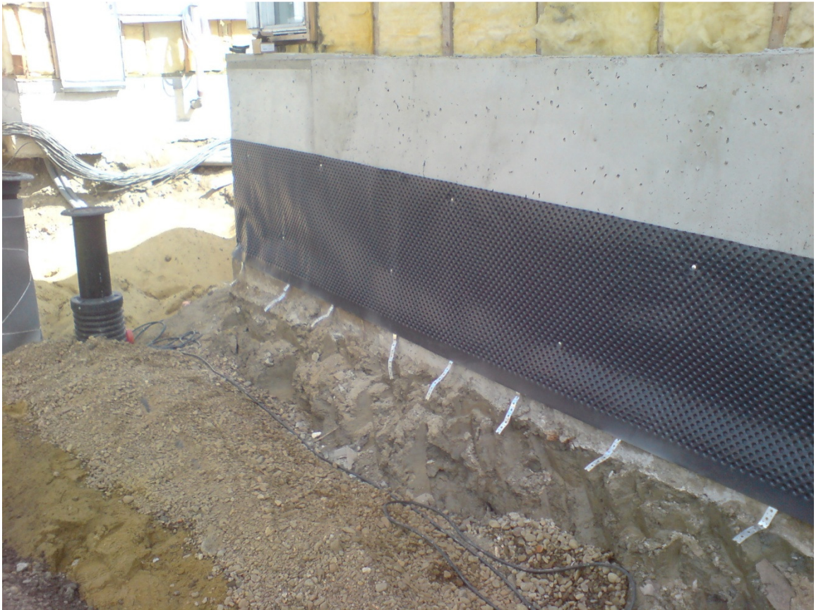
Kuva 3. Patolevyn asennus.
