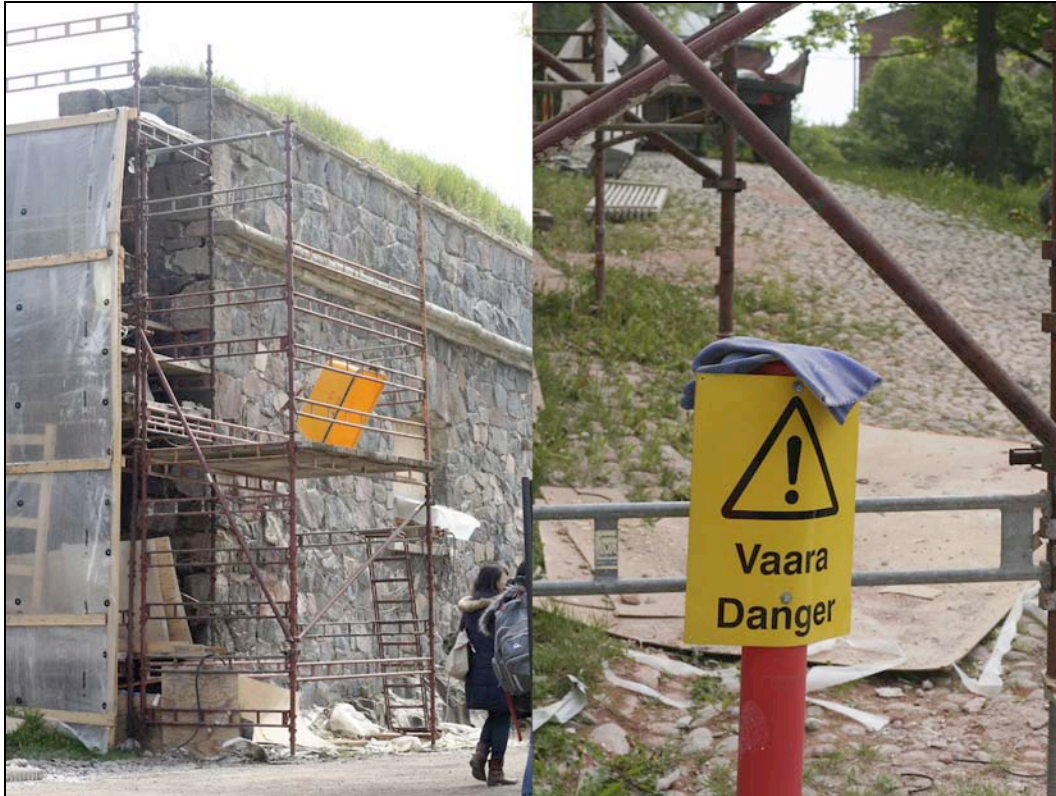
Kuvio 31. Eri tavoin merkityt rakennustyömaat
