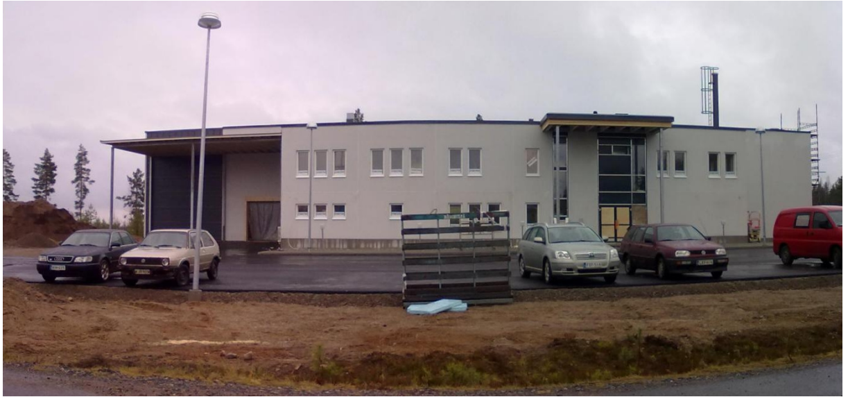
Kuva 1. Ylämyllylle noussut tehdas harjakorkeudessa
