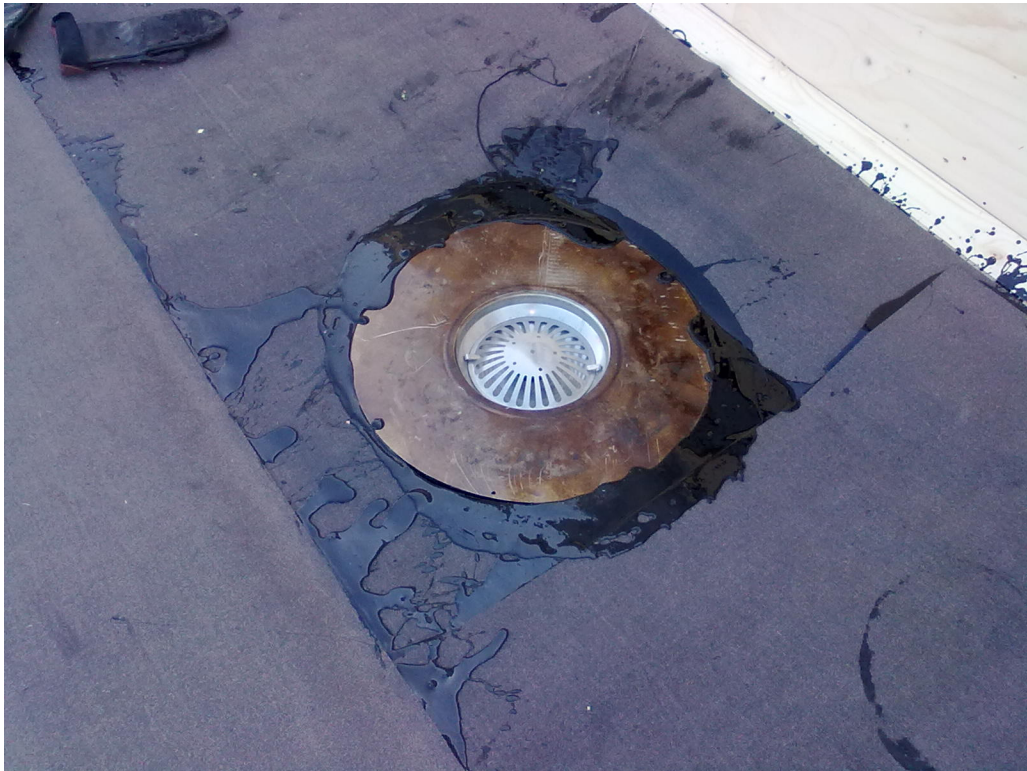
Kuva 13. Kattokaivo (B50 / HST + sähkövastus 230V/16W) liimattuna aluskermiin
