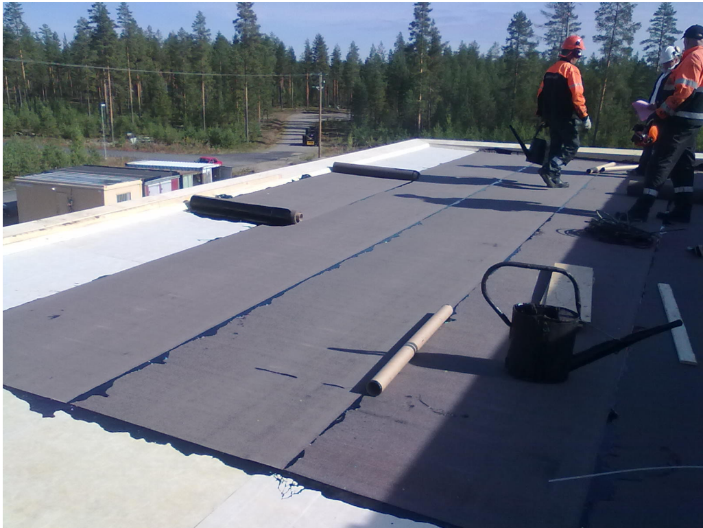
Kuva 11. Aluskermiä asennetaan liimaamalla
