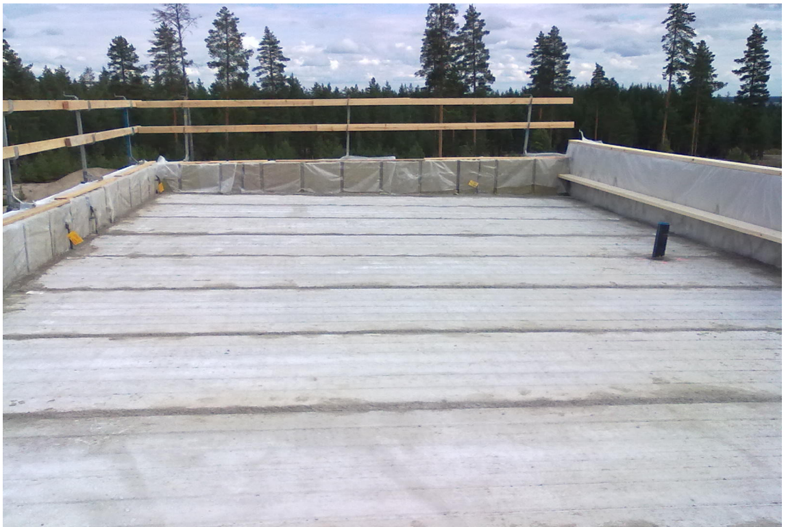
Kuva 2. Toimisto-osan katto ennen töiden aloitusta
