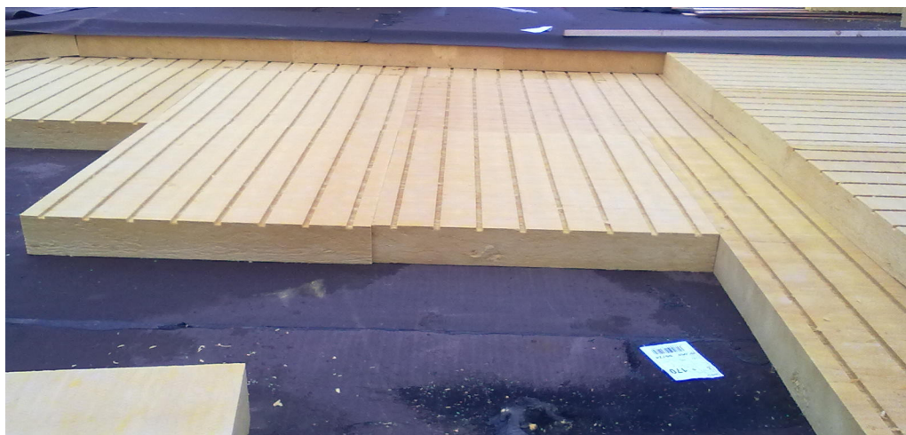
Kuva 7. Villojen asettelu höyrynsulun päälle
