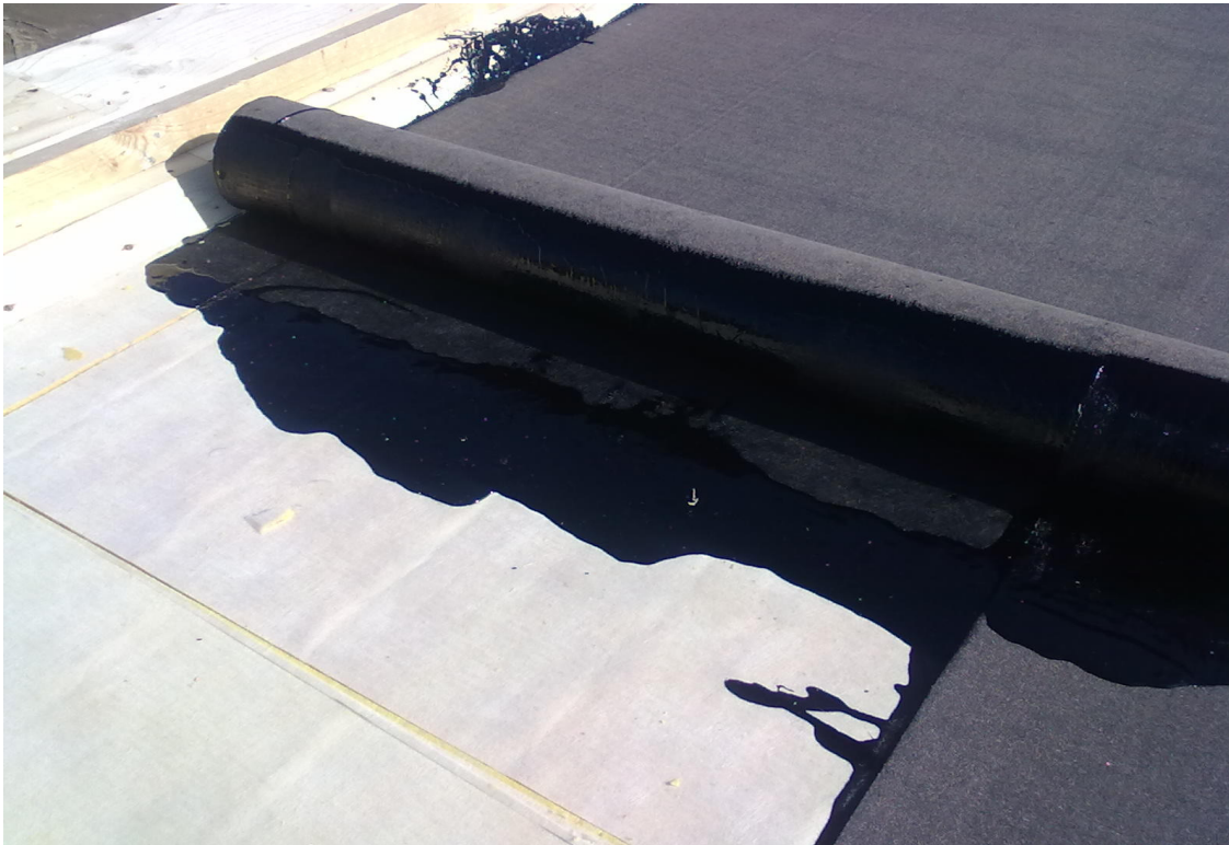
Kuva 12. Aluskermin kiinnitys puhalletulla bitumilla läpi liimaamalla
