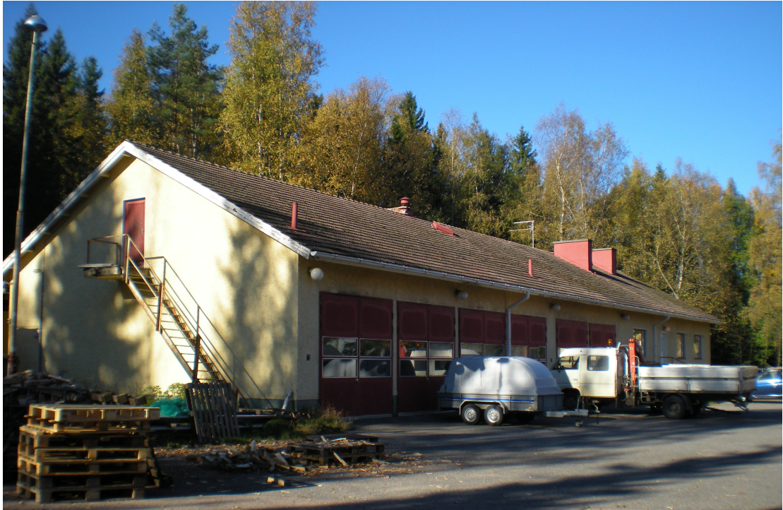
Kuva 1: Rakennus hallien päädystä kuvattuna.
