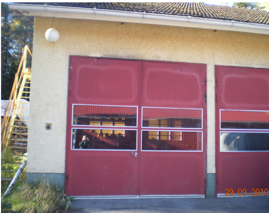
Kuva 4: Hallien ovia. Ovissa yksinkertaiset ikkunat.
