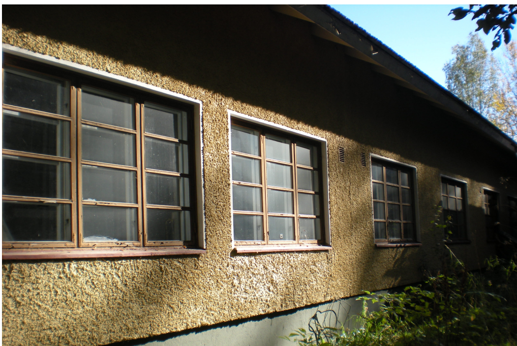
Kuva 5: Hallitilojen ikkunoita rakennuksen takana. Ikkunat kaksinkertaiset.
