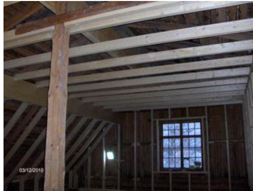
Kuva 20: Kattorungon suoraa osuutta nähtävillä (Kuva: Jari Ihainen)
