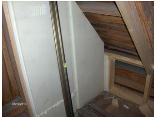
Kuva 21: Seinän lämpöeristys on aloitettu (Kuva: Jari Ihainen)
