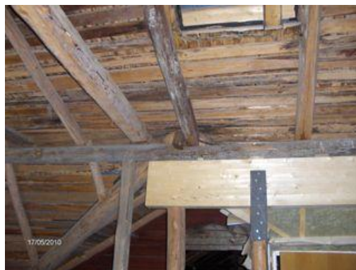
Kuva 17: Liimapuupalkki on asennettu (Kuva: Jari Ihainen)
