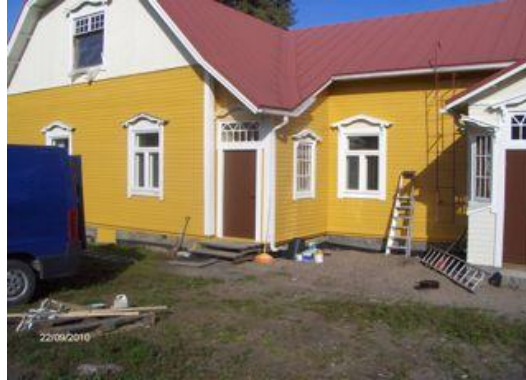
Kuva 1: 1920 tehty laajennus, rakennuksen pääty(Kuva: Jari Ihainen)
