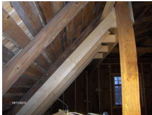
Kuva 15: Uuden sisäkaton liittymä kertopuupalkkiin (Kuva: Jari Ihainen)
