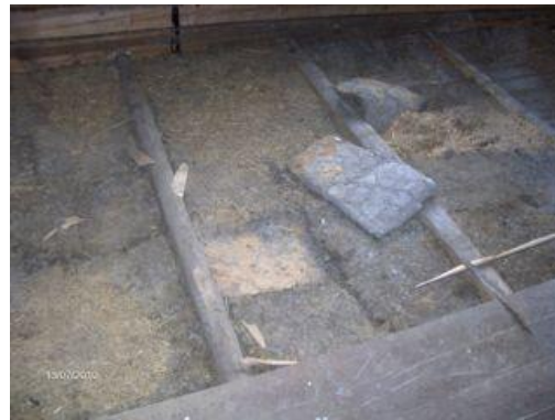
Kuva 3: Välipohjanrakenne, laudoitus on avattu (Kuva: Jari Ihainen)
