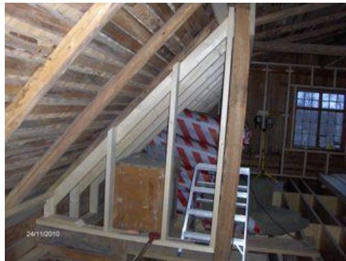
Kuva 19: Vinon sisäkaton ja vanhan katon tuuletusväli näkyvissä (Kuva: Jari Ihainen)
