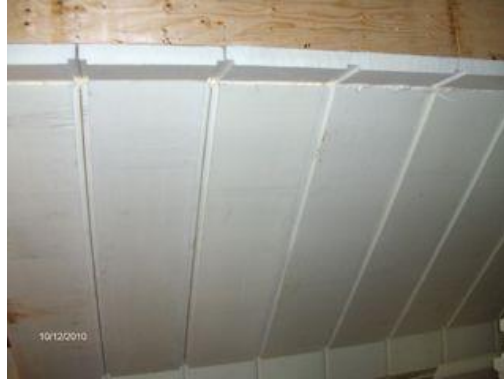
Kuva 22: Kattoeristeiden asennus on aloitettu (Kuva: Jari Ihainen)
