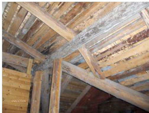
Kuva 16: Jiiri ennen liimapuupalkin asennusta (Kuva: Jari Ihainen)
