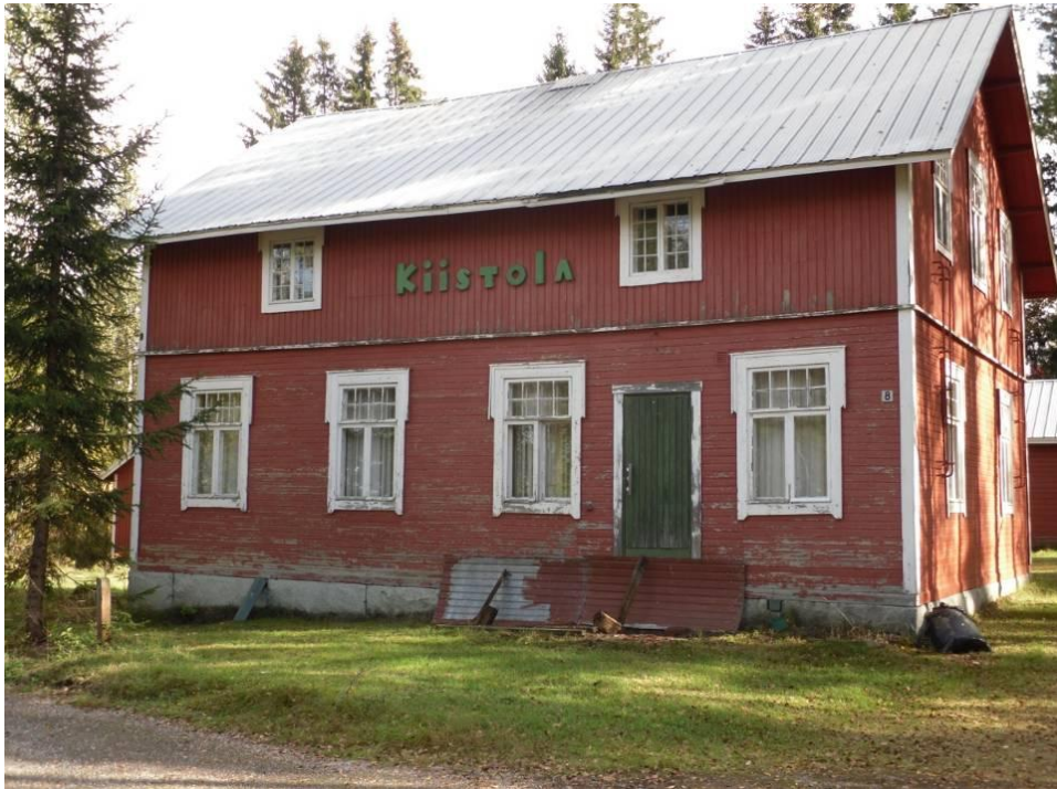
Kuva 4. Kadunpuoleinen julkisivu kesällä 2010.
