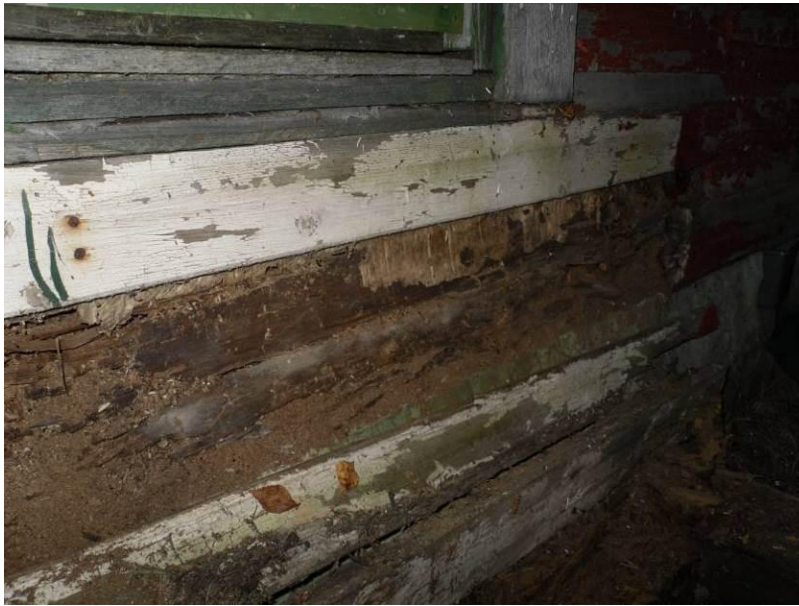
Kuva 17. Kuvassa näkyvät kadunpuoleisen oven alapuoliset hirret.
