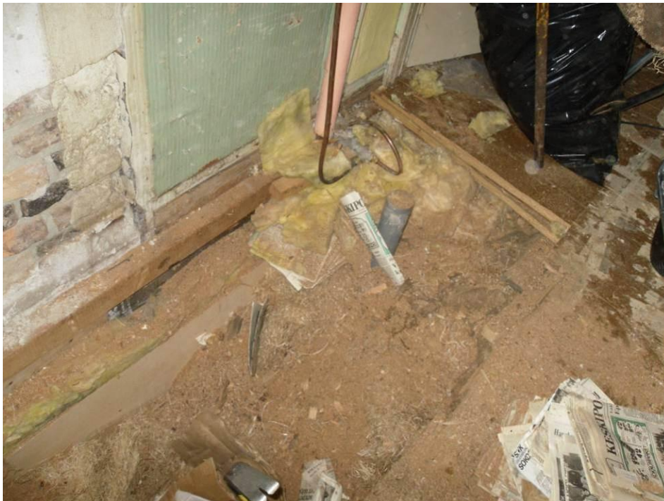
Kuva 10. Rossipohjan sahanpurueristeet näkyvät eteistilan ryömintätilan sisäänkäyntiaukon yhteydessä.
