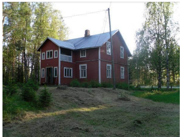
Kuva 7. Kuisti ja keittiönpääty.
