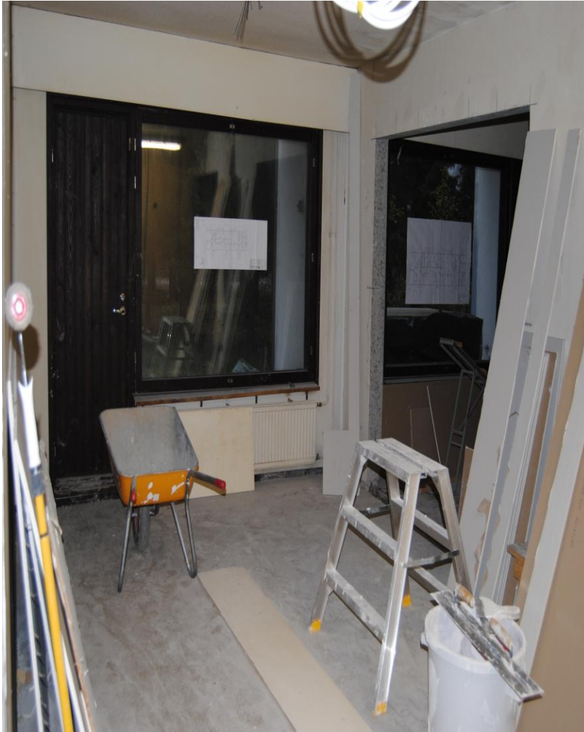
KUVA 21. Työmaavaiheessa olevan palvelukodin ruokailu- ja oleskelutila
