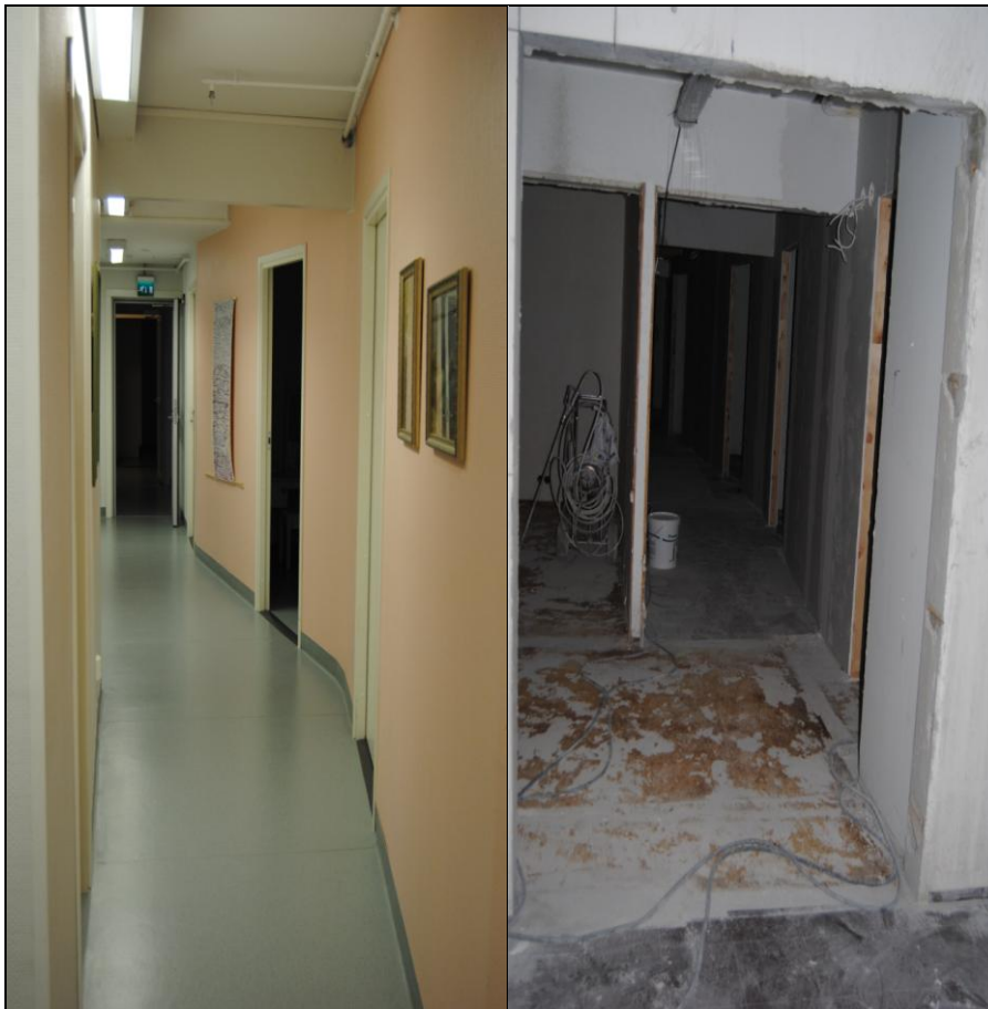
KUVA 18. Palvelukoti Akseliinan käytävä ja palvelukoti Oklaholmankatu 24:n aula ja käytävätilat työmaavaiheessa
