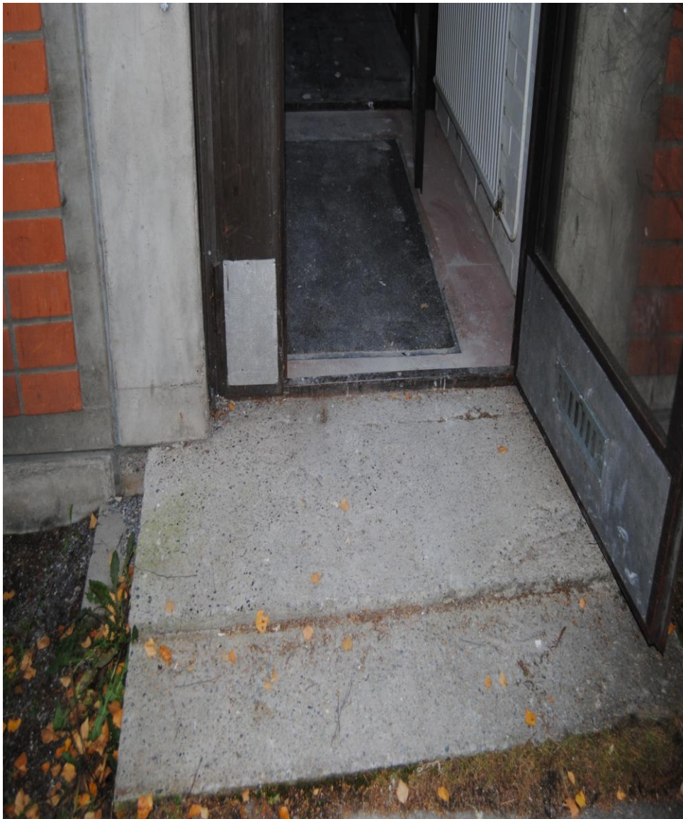
KUVA 15. Oklaholmankatu 24:n sisäänkäynnin yhteydessä oleva tasanne ja portaat
