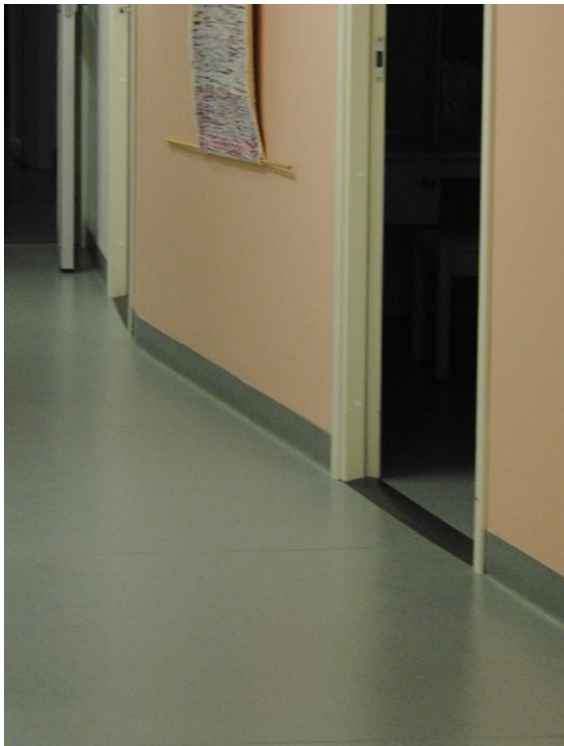
KUVA 22. Sisäoven kynnyksratkaisu (Palvelukoti Akseliina)
