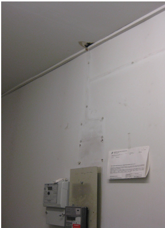
Teknisten tilojen pintojen kunnostus.
