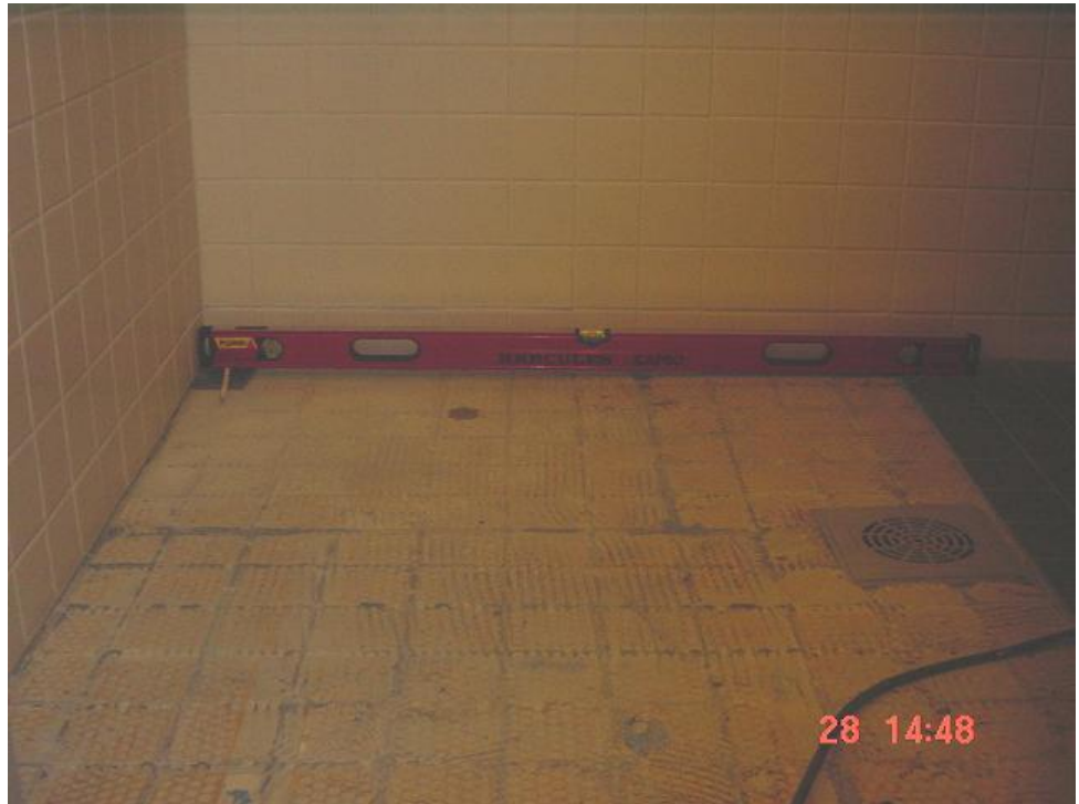
Kuva 3 Lattiakaadon korjauksesta johtuvat purkutoimenpiteet /12/
