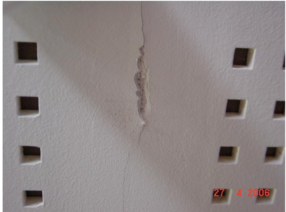
Kuva 8 Kipsilevyalakaton saumassa on käytetty lasikuitusaumanauhaa, joka on aiheuttanut halkeamisen /12/.
