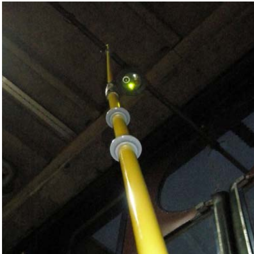
Kuva 1. Ajolangan jännitteenkoetin maadoitussauvassa (VR:n raivausraportit)
